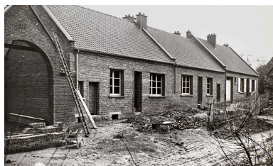
Logements d'ouvriers agricoles reconstruits, ferme Becquer, par Jean Hubert photographe à Amiens, 25 mars 1952 (AD Somme ; 1272 W 515).
