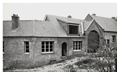
Maison d'habitation et porte charretière de la ferme Becquer reconstruites, par Jean Hubert photographe à Amiens, 25 mars 1952 (AD Somme ; 1272 W 515).
