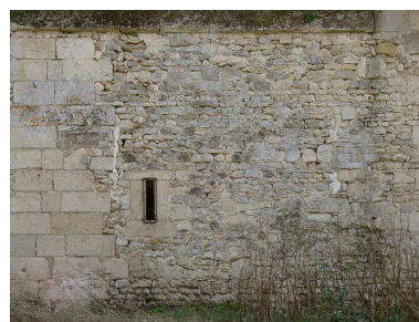
Détail de la maçonnerie du mur d'enceinte nord-ouest.
