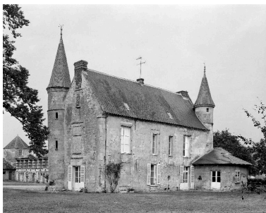
Vue du logis depuis l'est. Phot. Thierry Lefébure IVR22_19900202076V
