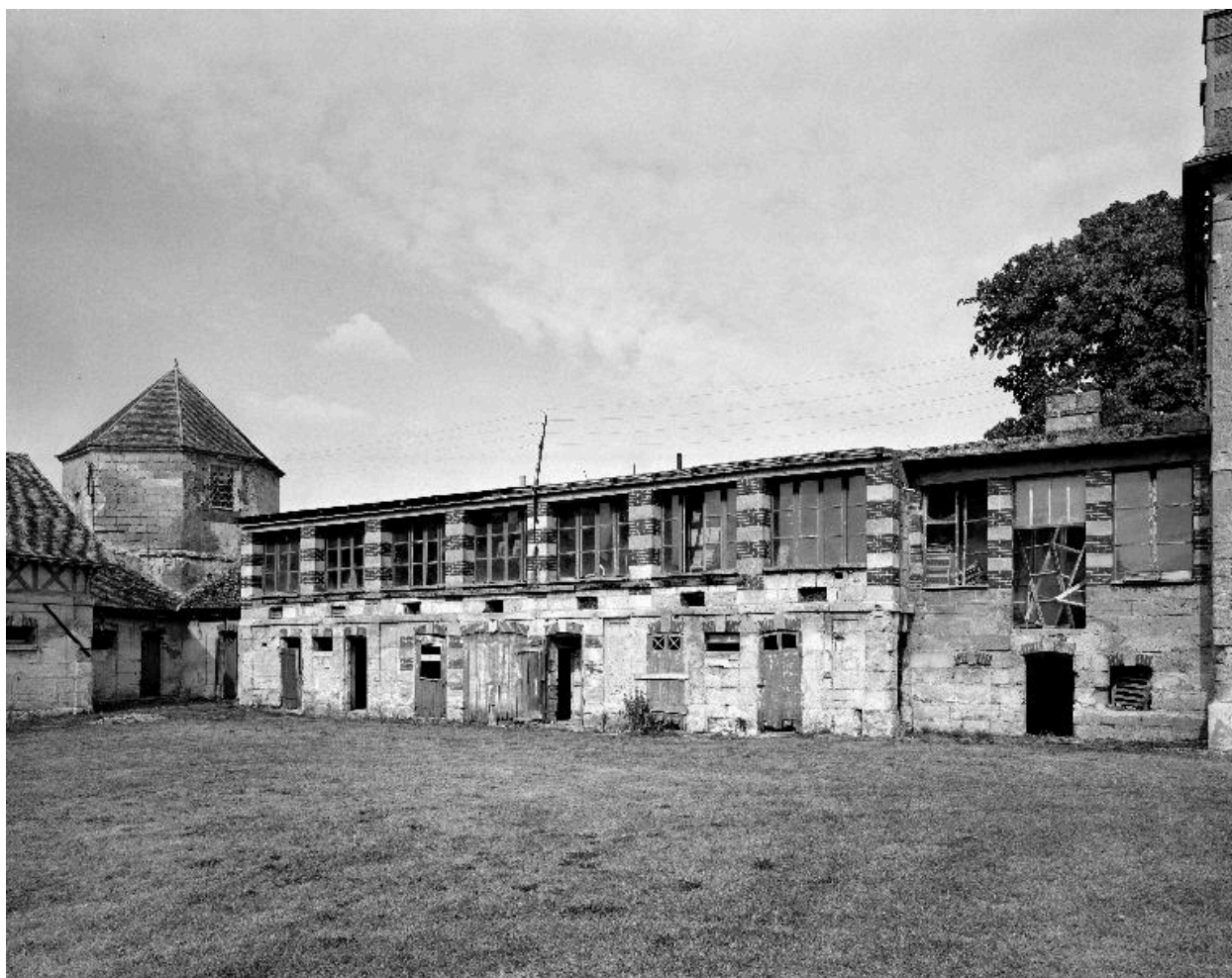
Vue de l'élévation sur cour de l'aile nord-ouest des communs.
