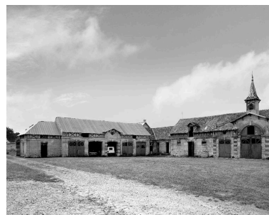
Vue partielle des communs depuis le nord. Phot. Thierry Lefébure IVR22_19900201988V
