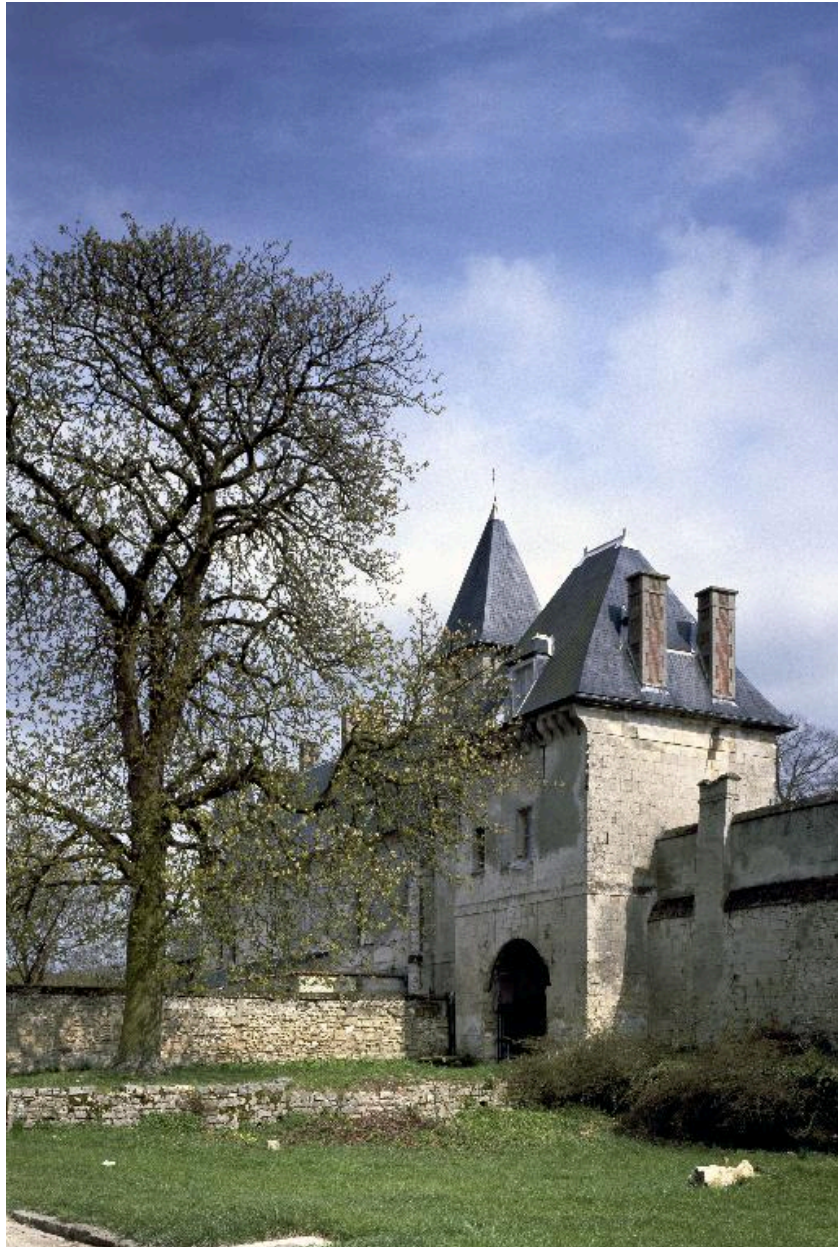
Vue extérieure de l'ouvrage d'entrée, depuis l'ouest.
