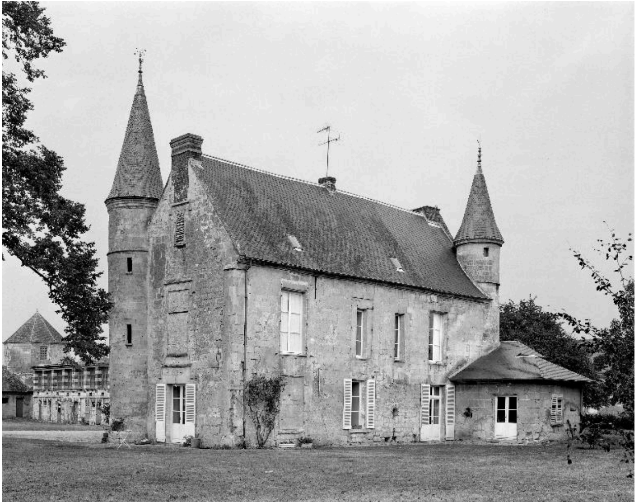
Vue du logis depuis l'est.
