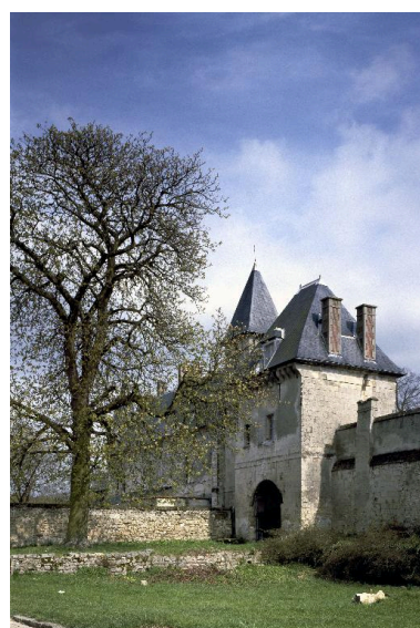
Vue extérieure de l'ouvrage d'entrée, depuis l'ouest.
