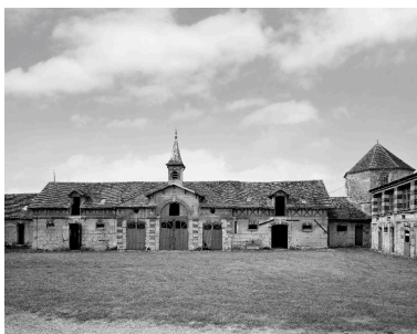
Vue de l'élévation sur cour de l'aile sud-ouest des communs (remises et écuries). Phot. Thierry Lefébure IVR22_19900201989V
