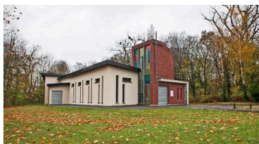
Vue générale de l'église reconstruite en 2007. Phot. Hubert Bouvet IVR31_20106201218NUCA
