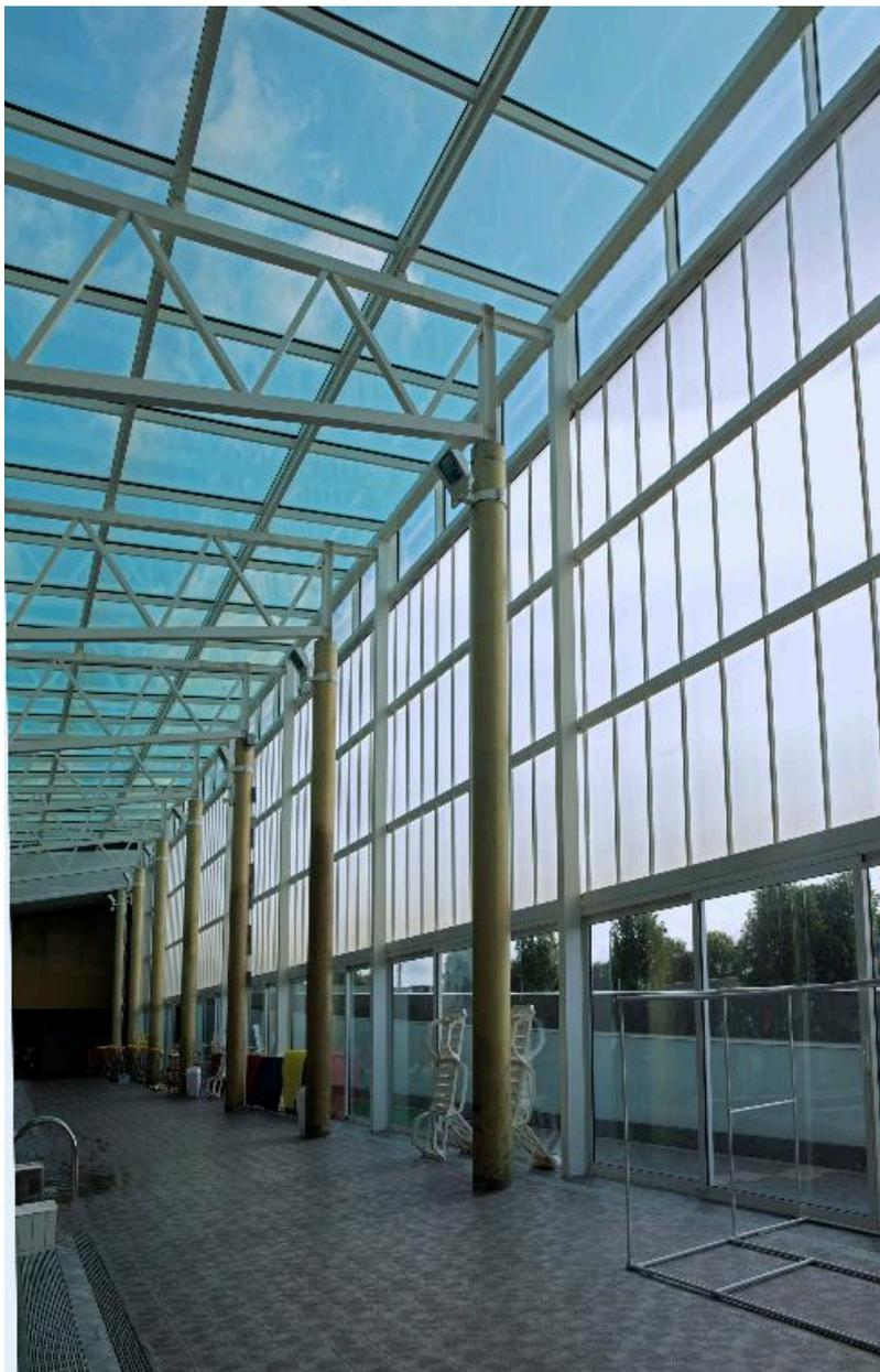
Façade est (côté bassin d'apprentissage), ouverte sur l'extérieure par des parois vitrées translucides (partie haute) et transparentes (partie basse); partie couverte d'une verrière.
