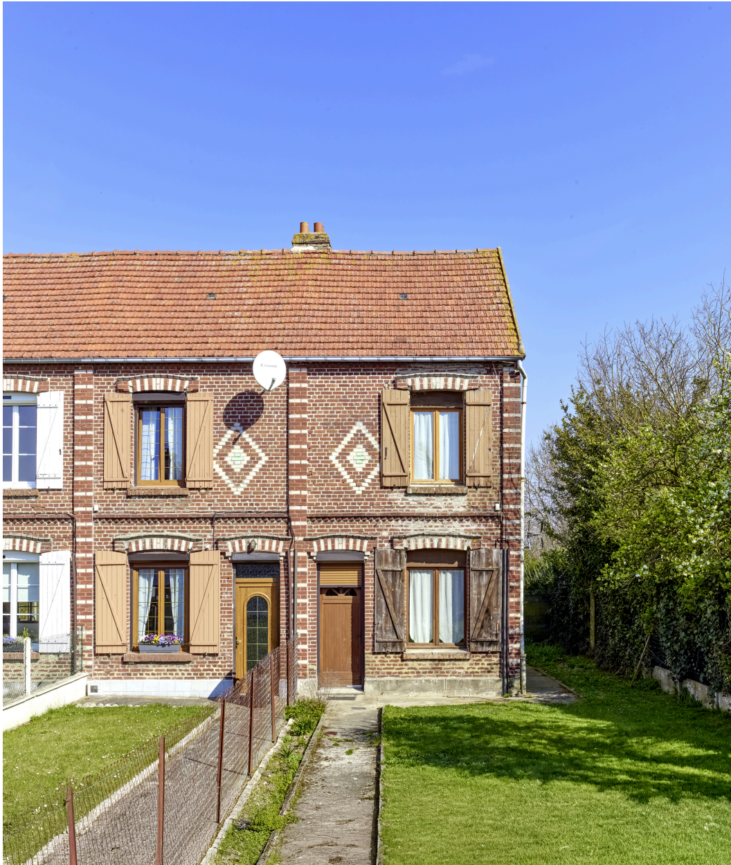
Détail des deux maisons de droite.
