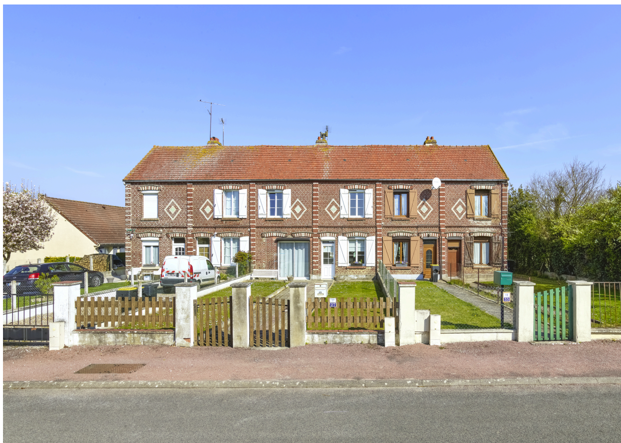
Vue d'ensemble de l'alignement des maisons.
