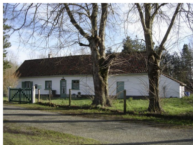
Vue générale. Phot. Inès Guérin IVR22_20078005374NUCA
