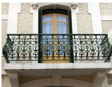
Détail du garde-corps de balcon en fonderie. Phot. Elisabeth Justome IVR22_20058003477NUCA
