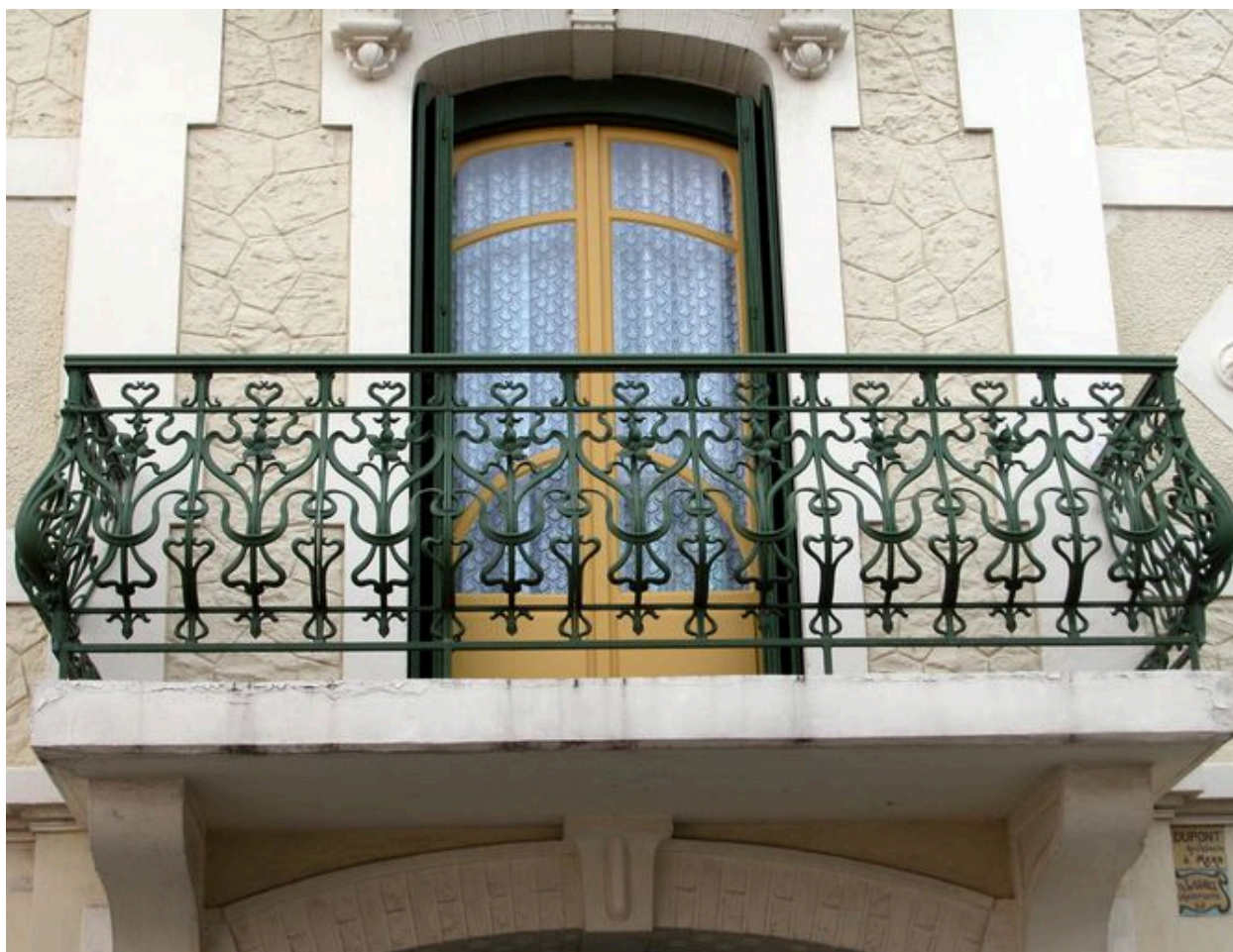
Détail du garde-corps de balcon en fonderie.
