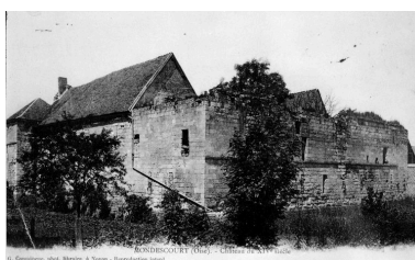
Le château, avant 1914 (AP). Phot. Jean-Michel Périn IVR22_19856000345XB
