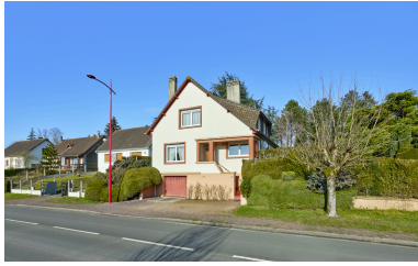
Maison, depuis le sud. Phot. Thierry Lefébure IVR32_20258000237NUCA
