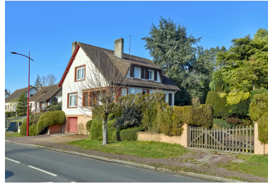
Maison, depuis le sud-est. Phot. Thierry Lefébure IVR32_20258000238NUCA
