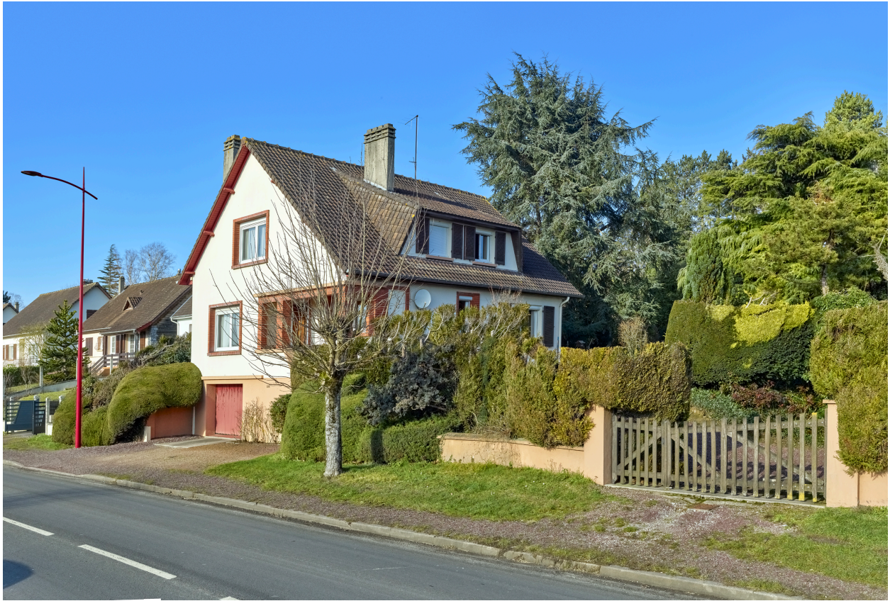
Maison, depuis le sud-est.
