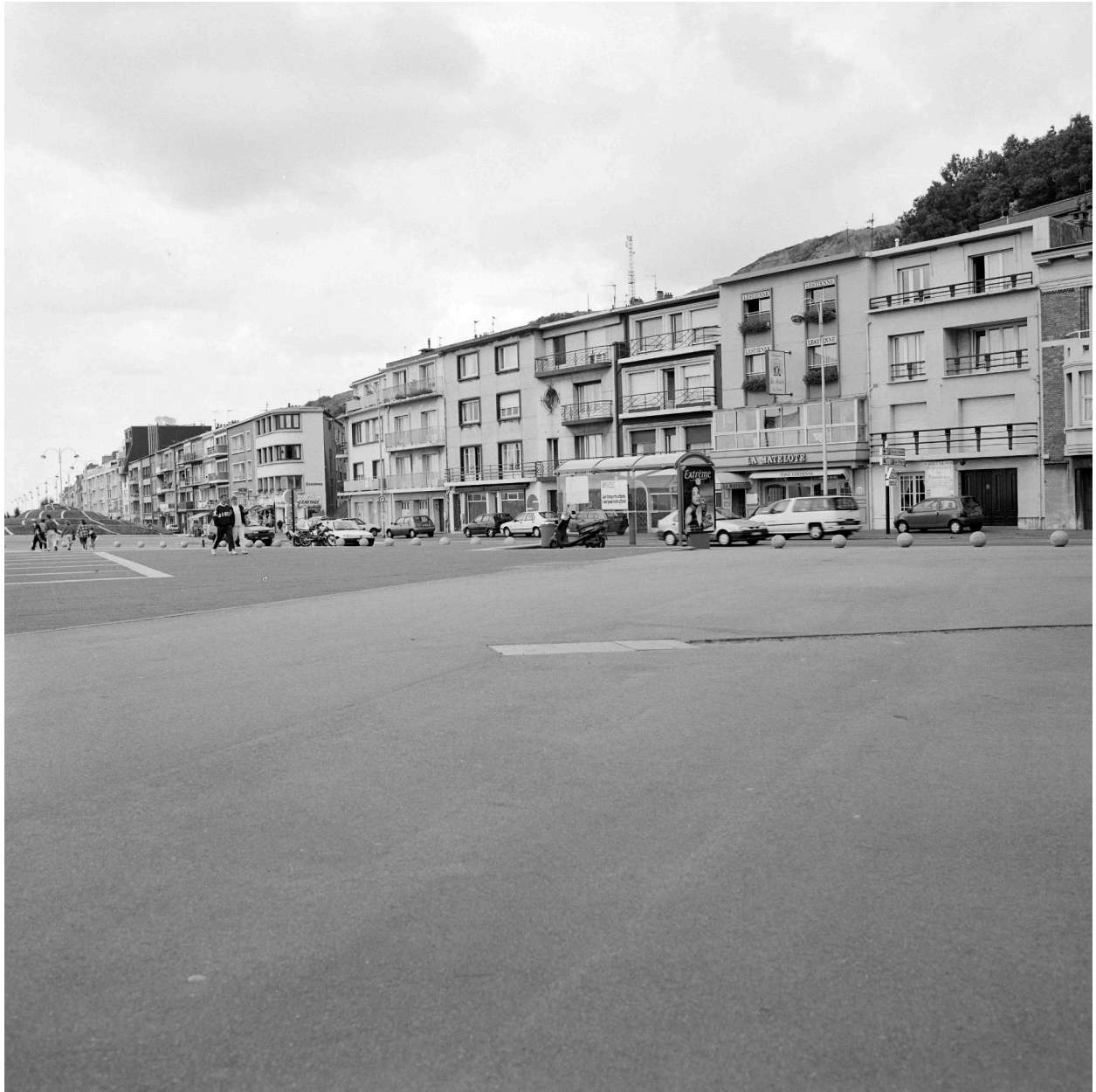
Reconstruction : boulevard Sainte-Beuve, façade sur la digue.
