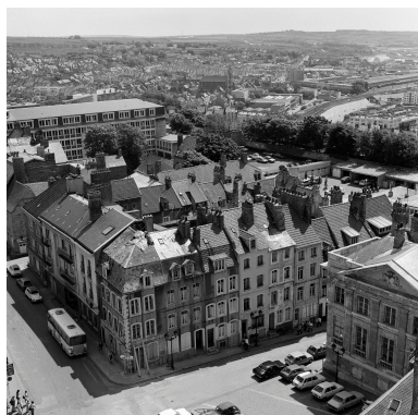
Vue de la haute ville vers la rue de Bréquerecque. Phot. Jean-Michel Périn, Phot. Éric Dessert IVR31_19806203062X
