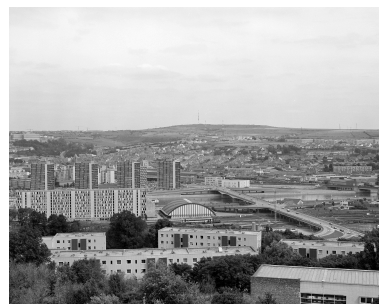
Vue aérienne : au premier plan, la Liane, au deuxième plan, le Mont Lambert. Phot. Éric Dessert, Phot. Philippe Caudroit IVR31_19806203225X
