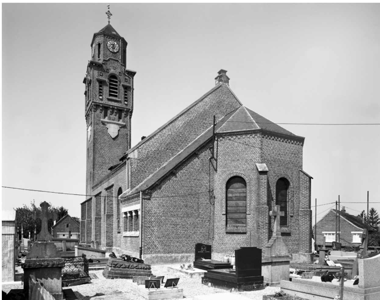
Vue générale sud-est de l'église reconstruite.
