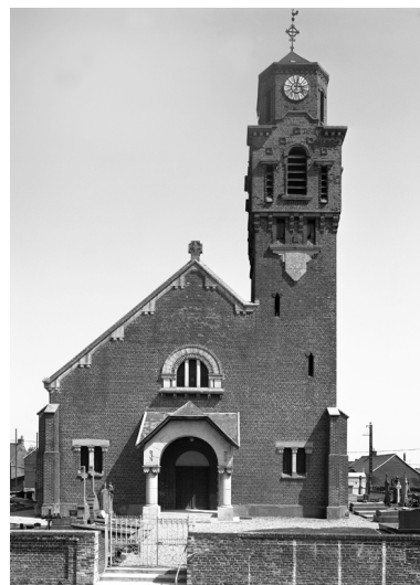
Elévation occidentale. Phot. Thierry Lefébure IVR22_19930200455V
