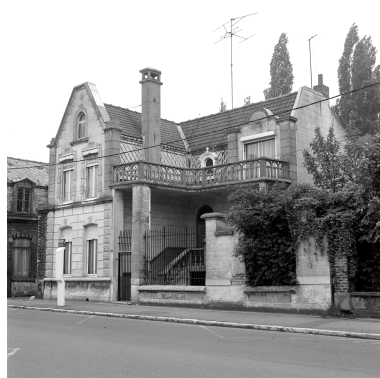
Bureau, élévation antérieure. Phot. Philippe Dapvril IVR31_19885900748X
