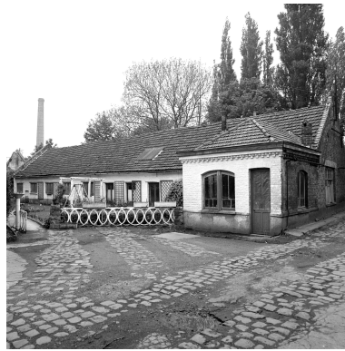
Ancienne buanderie, au premier plan, et magasin aux matières travaillées. Phot. Philippe Dapvril IVR31_19885900746X
