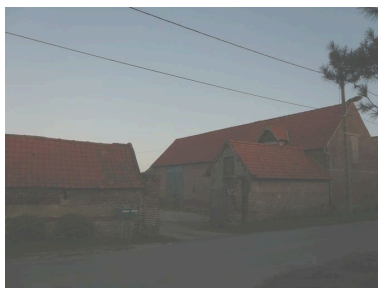
Entrée de la propriété. Phot. Inès Guérin IVR22_20058006392NUCA
