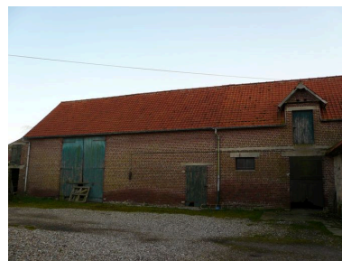
Vue de la grange. Phot. Inès Guérin IVR22_20058006396NUCA
