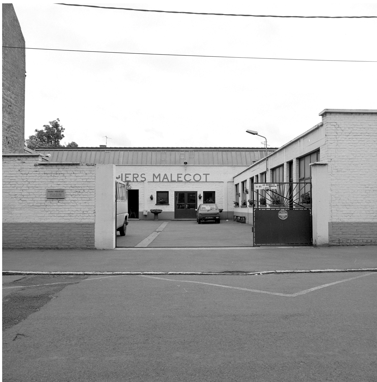
Atelier de fabrication rue Sadi-Carnot.
