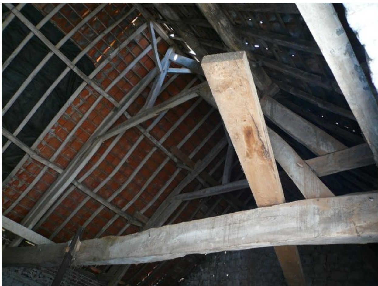
Vue de la charpente de la grange.
