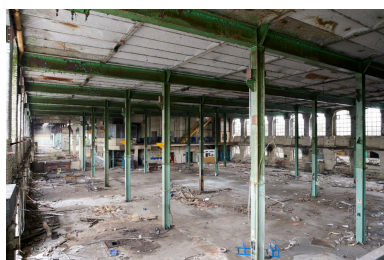
Vue intérieure de la filature (le plancher du rez-de-chaussée surélevé a été supprimé). Phot. Delphine Volto Jourdan IVR32_20215900389NUCA
