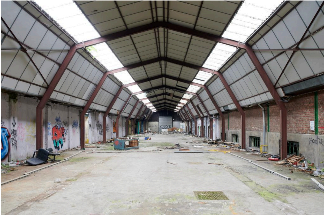
Vue intérieure de la charpente métallique à fermes polygonales du magasin nord.
