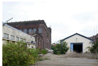
Vue générale vers l'est. Au droite, le magasin sud, à gauche, la filature et son prolongement (atelier ?) érigé dans les années 1960. Phot. Delphine Volto Jourdan IVR32_20215900414NUCA
