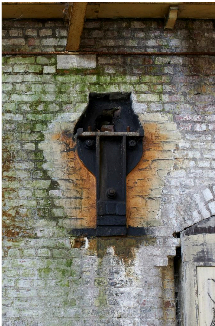
Intérieur de la filature. Au troisième étage, support métallique ancré au mur.
