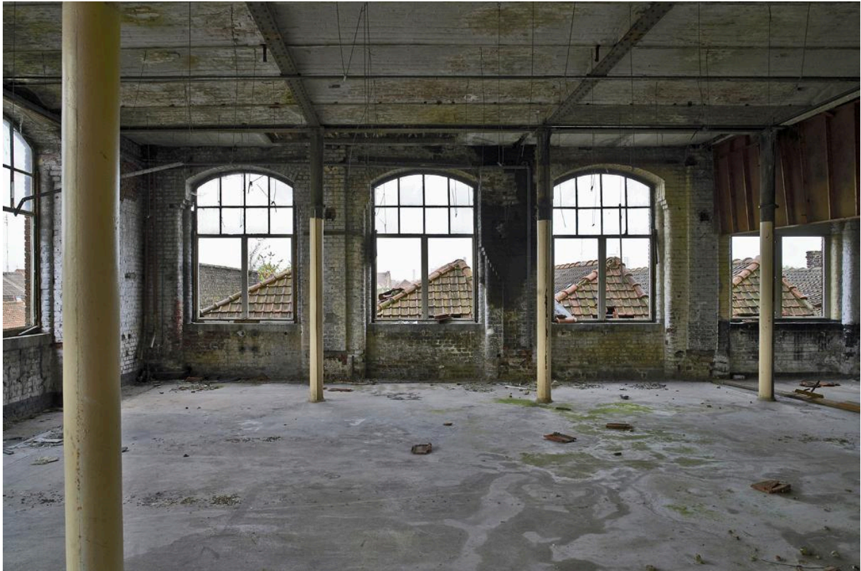
Vue intérieure de la filature. Vue longitudinale du deuxième étage.
