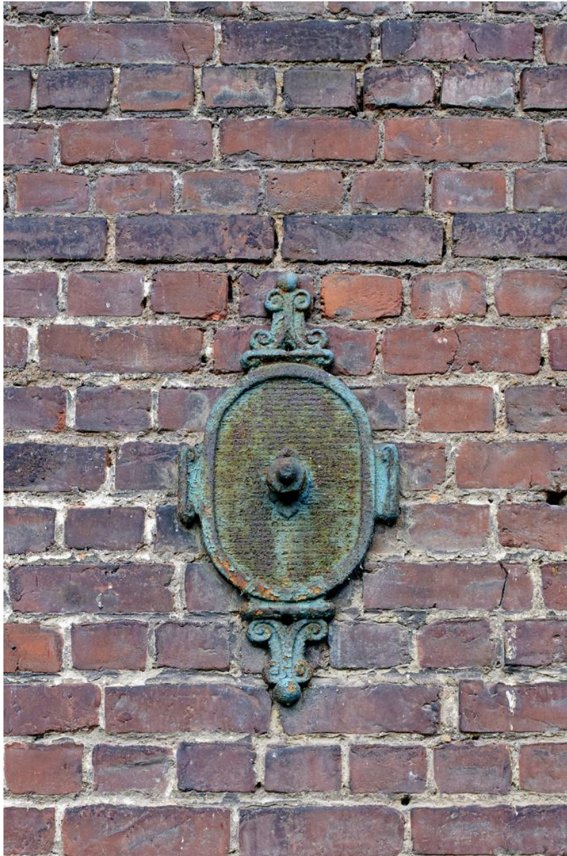
Fer d'ancrage sur l'élévation sud-est.
