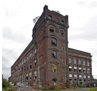
Vue de trois quarts de la filature, depuis la cour, vers le nord. Au premier plan la tour accueillant monte-charge et escalier de distribution. Phot. Delphine Volto Jourdan
