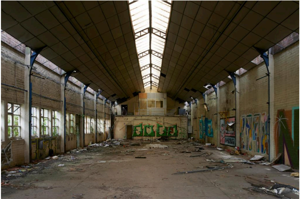
Vue intérieure du magasin sud.
