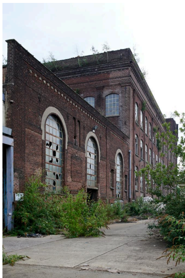
Élévation sud-ouest de la salle des machines, au premier plan, et de la filature. Phot. Delphine Volto Jourdan IVR32_20215900415NUCA
