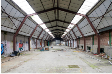
Vue intérieure de la charpente métallique à fermes polygonales du magasin nord. Phot. Delphine Volto Jourdan IVR32_20215900413NUCA
