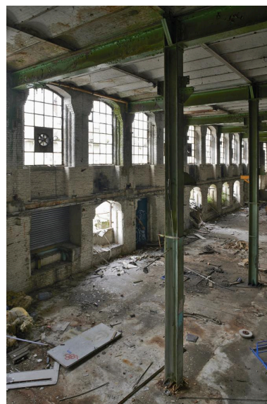
Vue intérieure de la filature (le plancher du rez-de-chaussée surélevé a été supprimé). Phot. Delphine Volto Jourdan IVR32_20215900393NUCA
