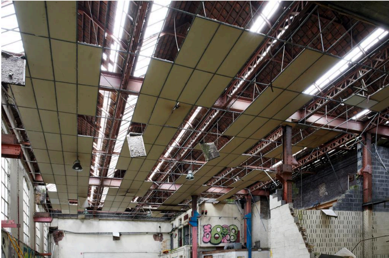
Charpente de la salle des machine depuis l'entrée. À droite, la cabine de commande.
