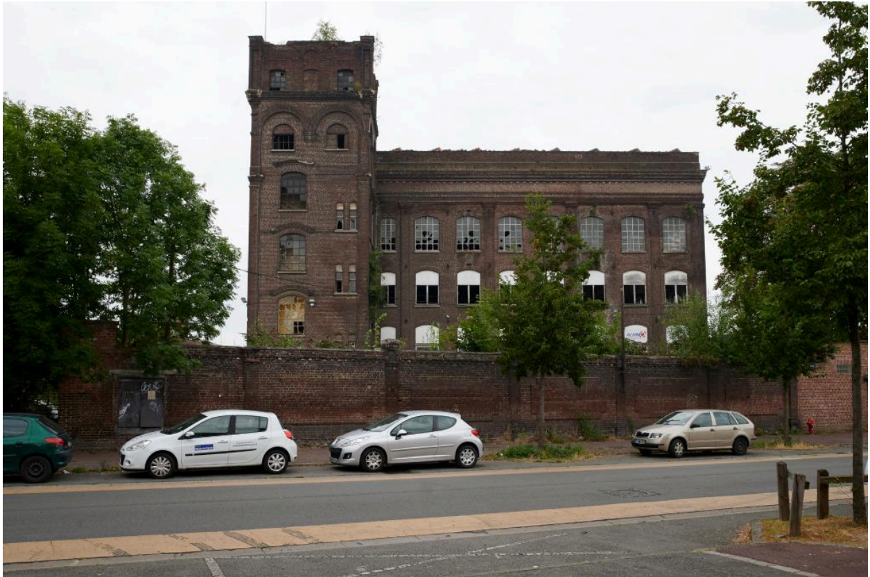
Vue générale depuis le boulevard de Reims, vers le nord-ouest.
