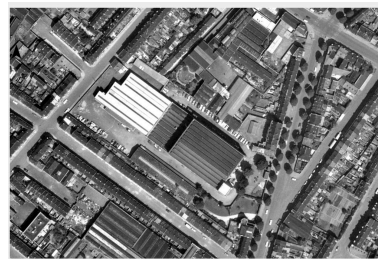
L'édifice sur une photographie aérienne de 1969 (Géoportail). Ajout de nouveaux ateliers ou magasins à l'ouest. Repro. Jean-Marc Ramette, Autr. Institut Géographique National IVR32_20215905014NUC
