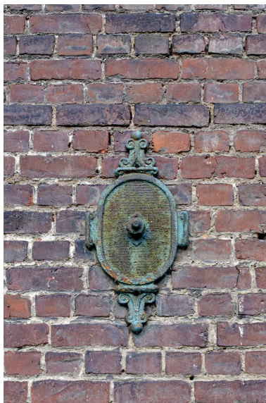
Fer d'ancrage sur l'élévation sud-est. Phot. Delphine Volto Jourdan IVR32_20215900388NUCA
