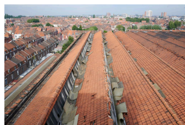
Vue générale vers le nord-ouest du couvrement de la filature depuis la terrasse de la tour maçonnée hors-oeuvre accolée à celle-ci. Phot. Delphine Volto Jourdan IVR32_20215900409NUCA
