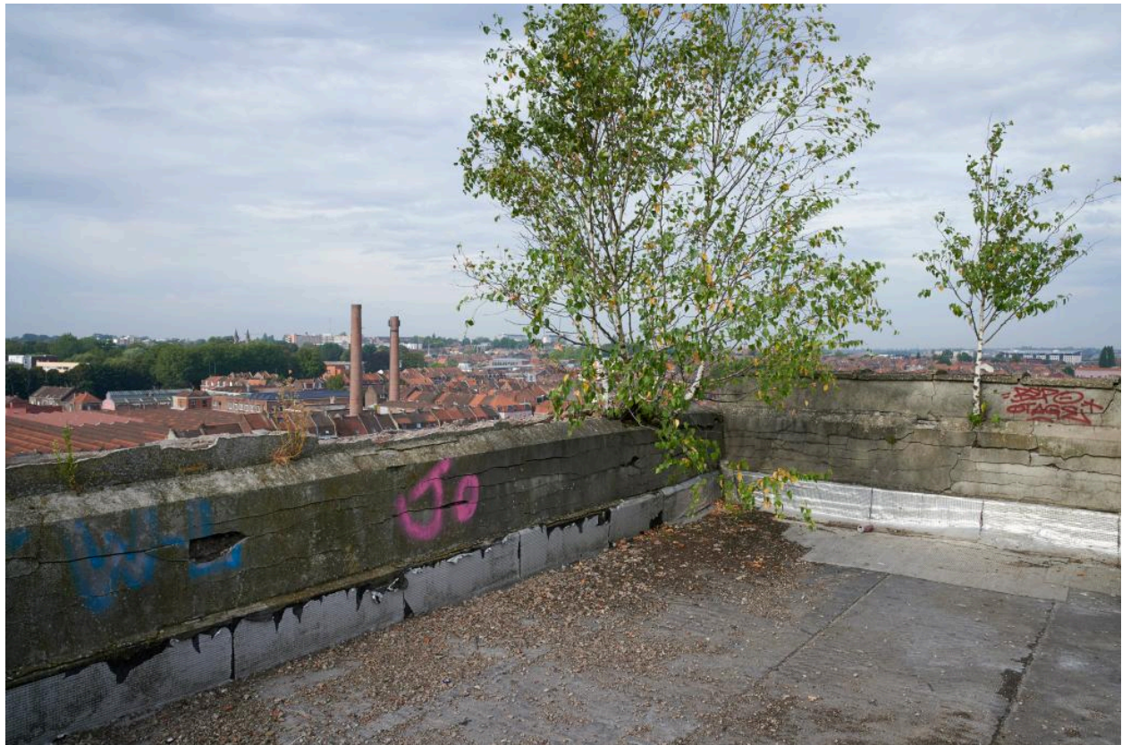
Terrasse couvrant la tour maçonnée hors-oeuvre distribuant les différents niveaux de la filature.
