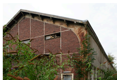
Détail du pignon sud-est en pans de fer et de la ferme métallique du magasin sud. Phot. Delphine Volto Jourdan IVR32_20215900387NUCA
