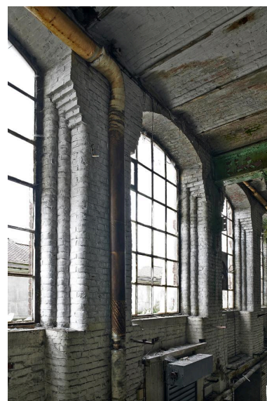
Vue intérieure de la filature (le plancher du rez-de-chaussée surélevé a été supprimé). Détails d'un trumeau. Phot. Delphine Volto Jourdan IVR32_20215900392NUCA
