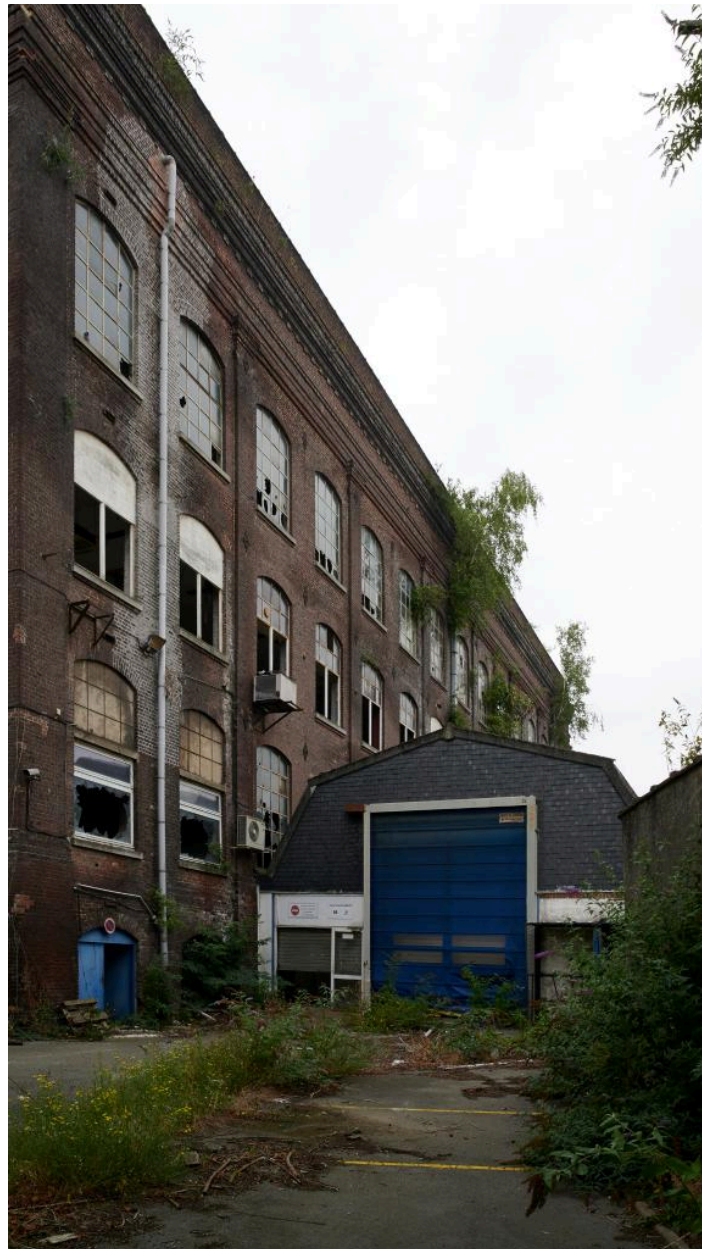
Magasin nord adossé à l'élévation nord-est de la filature.
