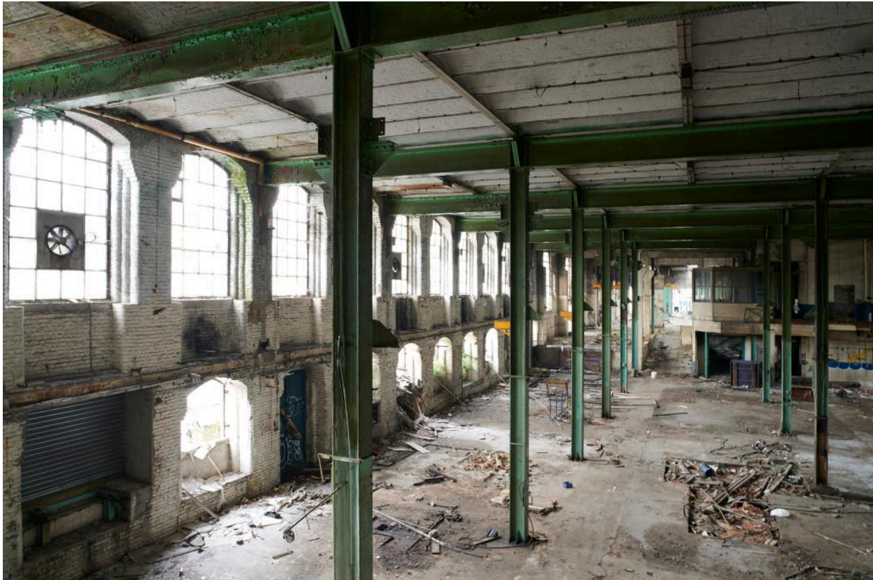
Vue intérieure de la filature (le plancher du rez-de-chaussée surélevé a été supprimé).
