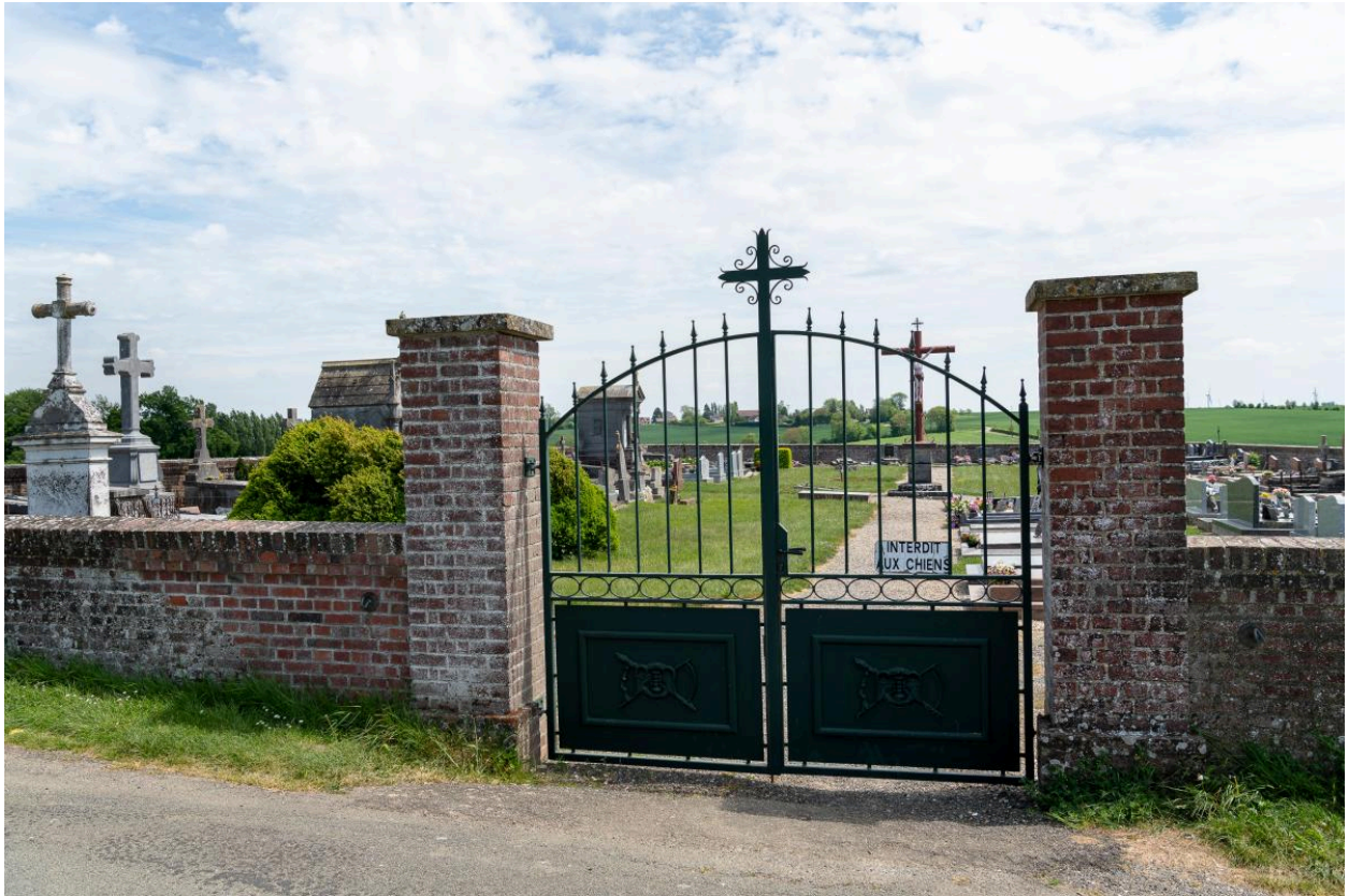
Entrée du cimetière depuis l'ouest.
