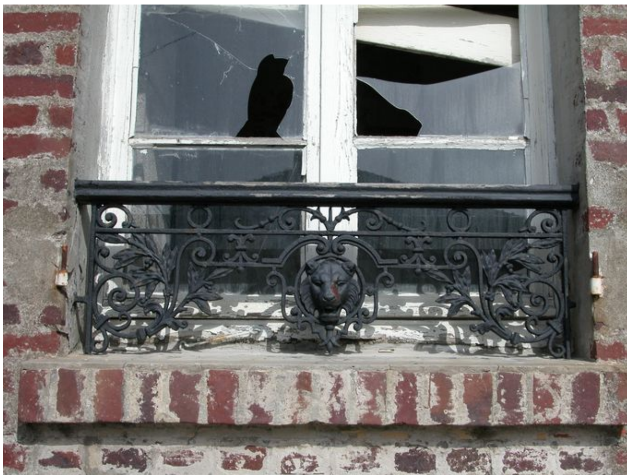
Détail d'un garde-corps en ferronnerie, rue Balzac.
