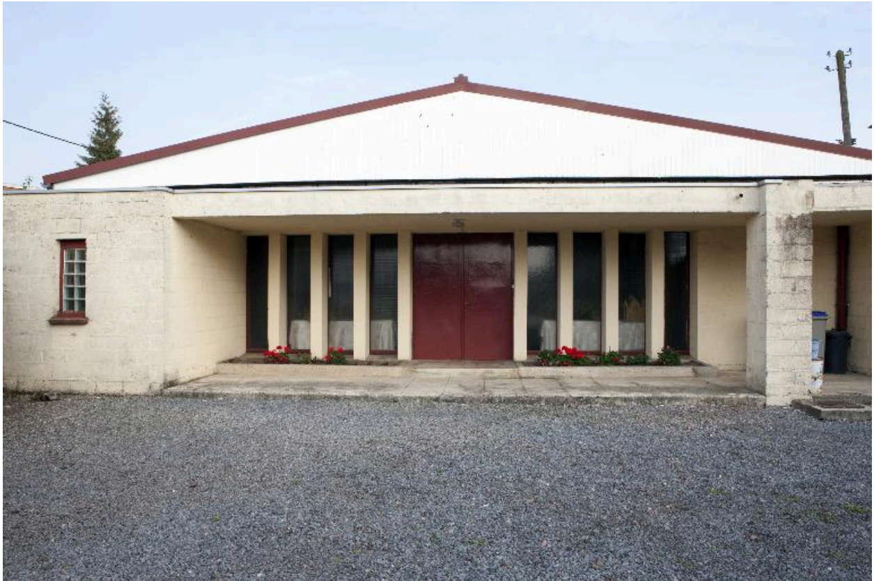
Élévation antérieure de la chapelle.
