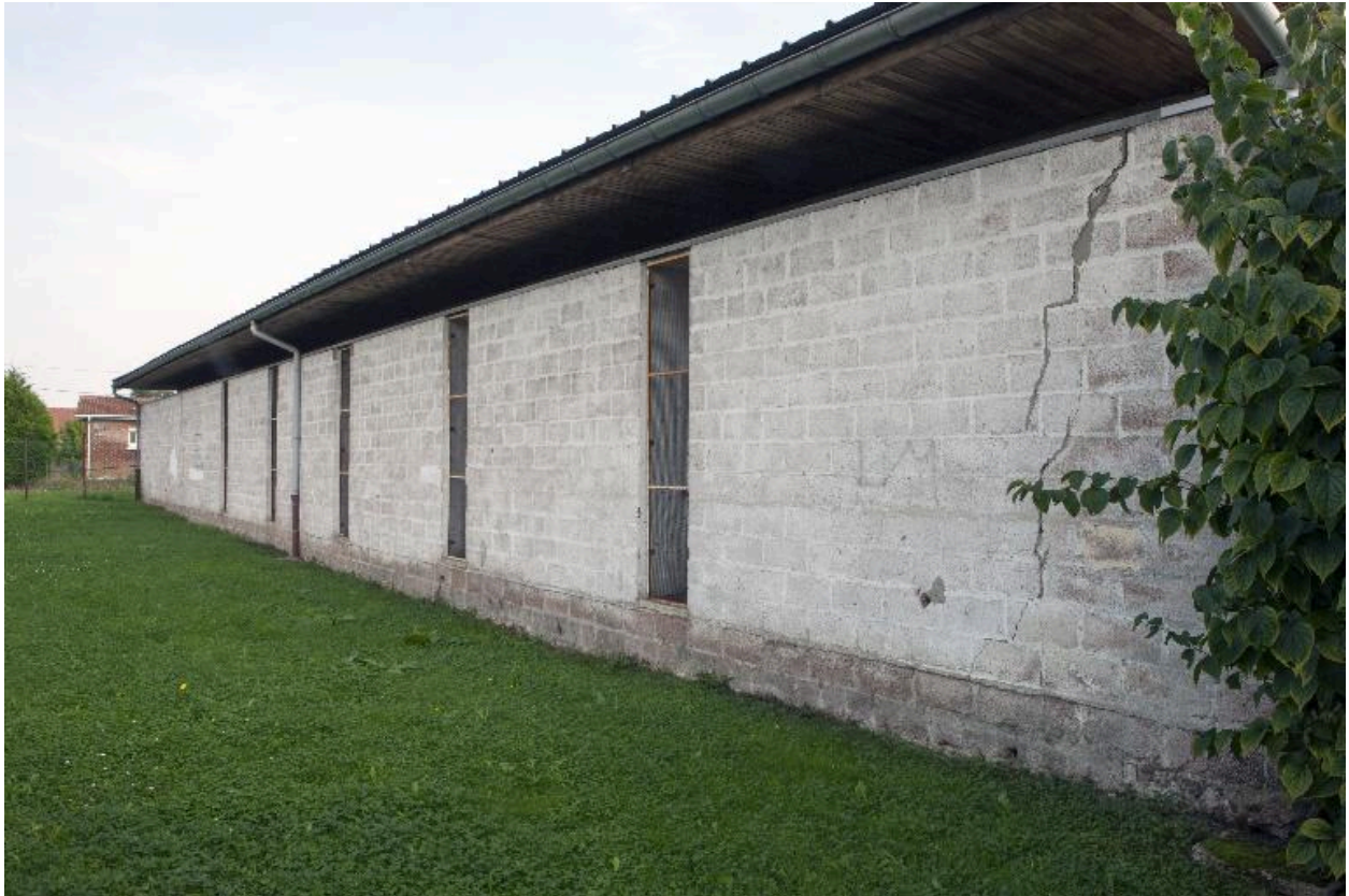
Élévation du flanc gauche de la chapelle.
