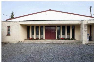
Élévation antérieure de la chapelle. Phot. Pierre Thibaut IVR31_20155900318NUCA
