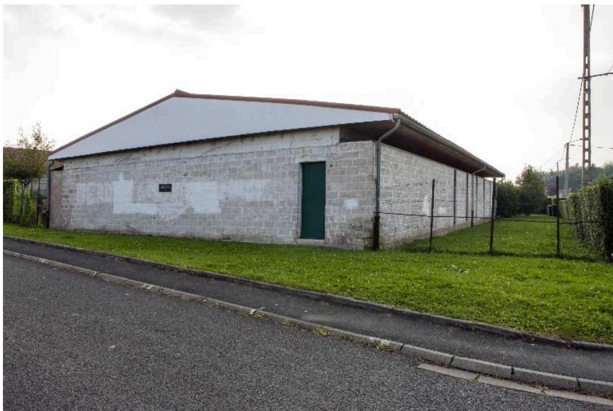
Élévation postérieure de la chapelle et flanc gauche.
