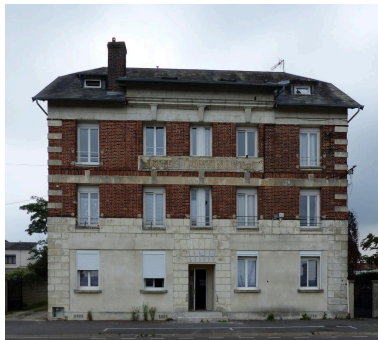
Vue de la façade sur rue. Phot. Isabelle Barbedor IVR32_20210205166NUCA
