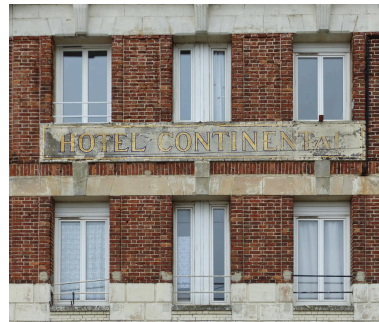
Vue de détail de la façade sur rue et du cartouche portant l'inscription HOTEL CONTINENTAL. Phot. Isabelle Barbedor IVR32_20210205167NUCA
