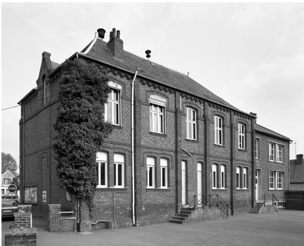
Vue de l'élevation postérieure, depuis le nord-ouest.
