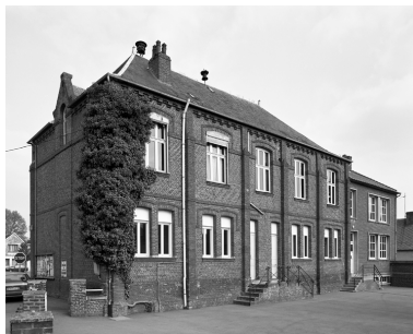
Vue de l'élévation postérieure, depuis le nord-ouest. Phot. Thierry Lefébure IVR22_19930200479V
