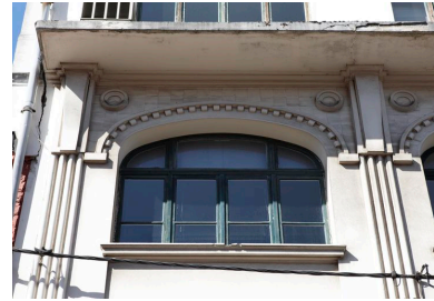
Décor du couronnement d'une baie du second étage. Phot. Pierre Thibaut IVR31_20096200281NUCA
