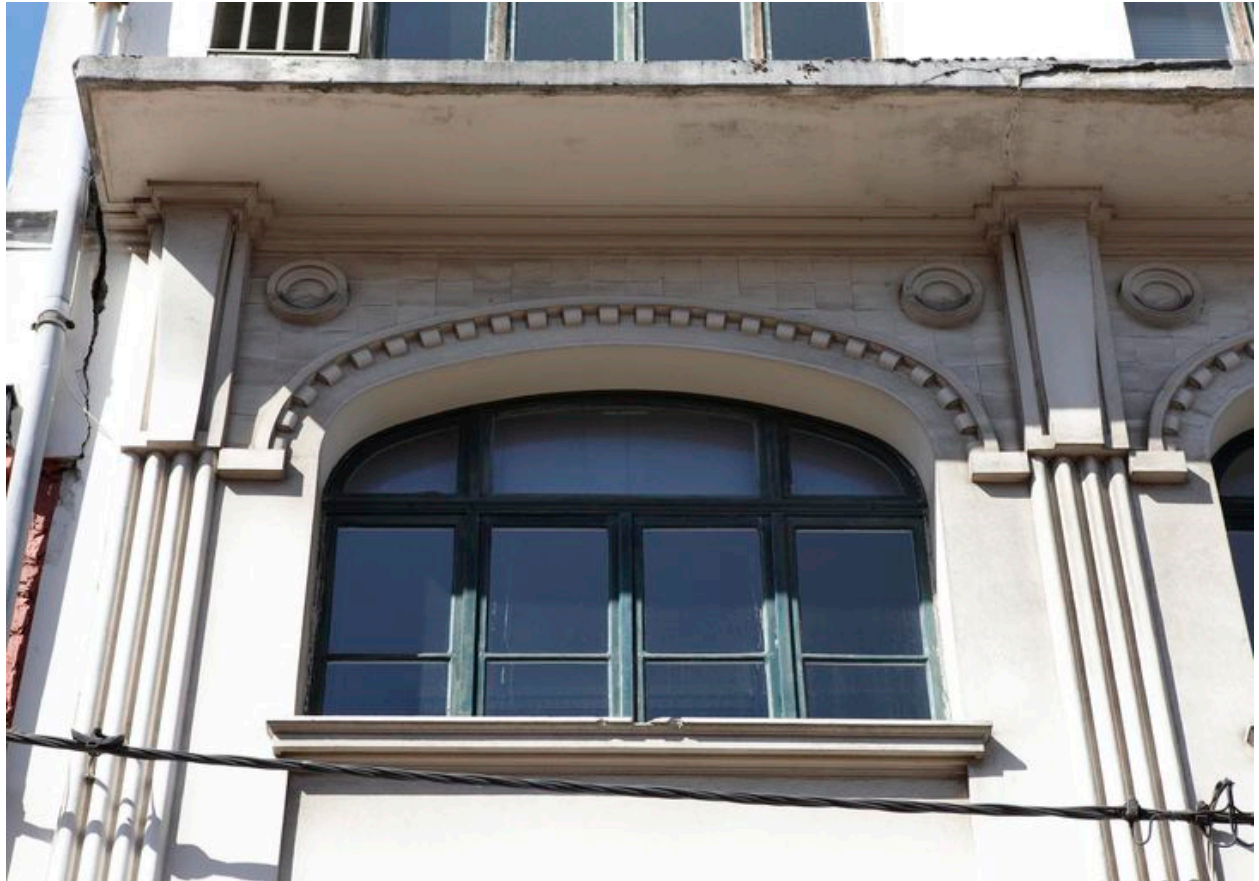
Décor du couronnement d'une baie du second étage.
