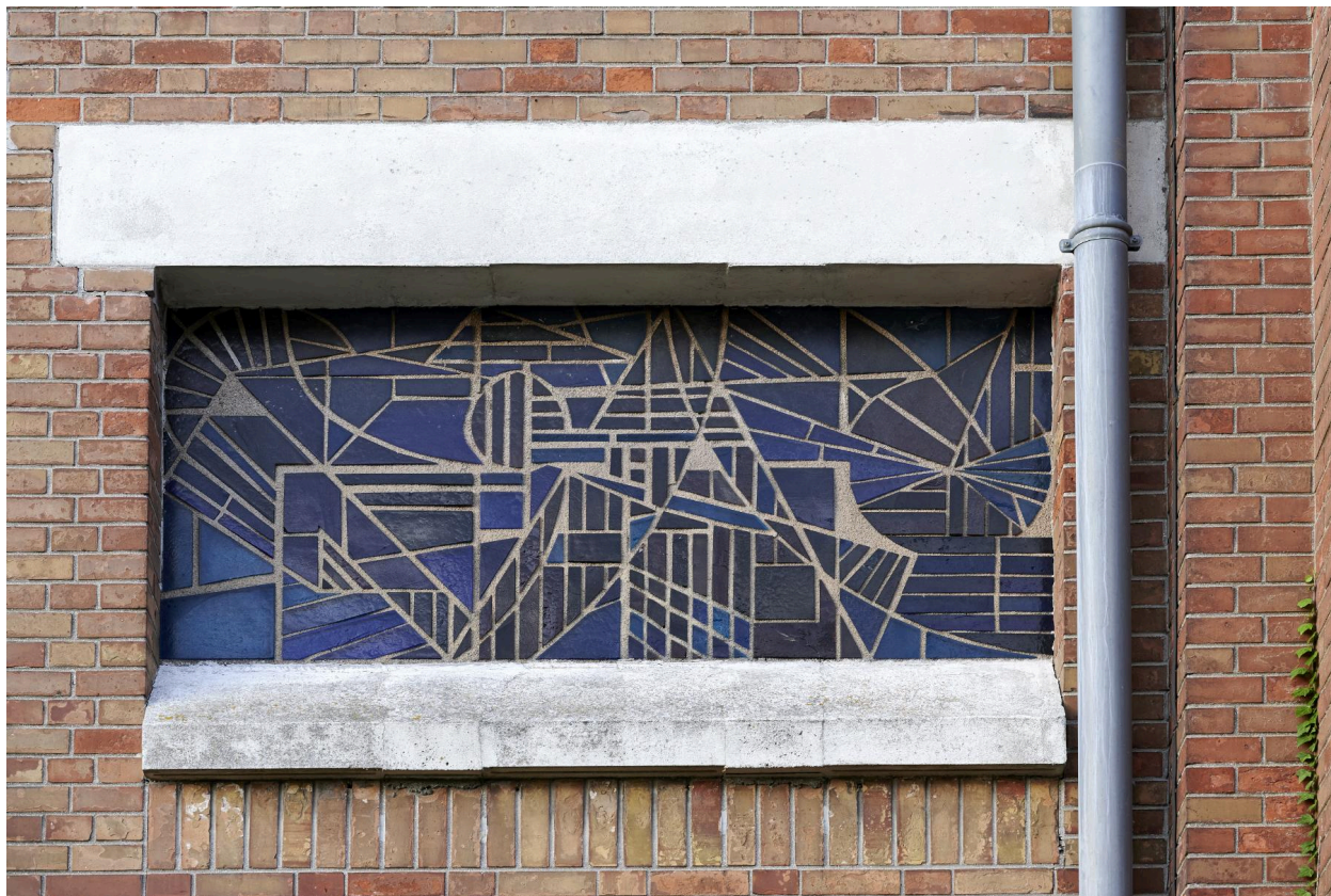
Vue extérieure de la baie 12 (chapelle des fonts baptismaux) : verrière à motifs géométriques. Verrière de Désiré et Françoise Waret réalisée par l'atelier Claude Barré, 1982.
