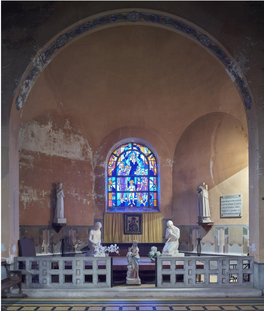
Vue générale de l'extrémité du transept nord (murs et arc peints à fresque par Valentine Reyre en 1928, banc de communion et verrière Notre-Dame par Waret, réalisée en 1982).
