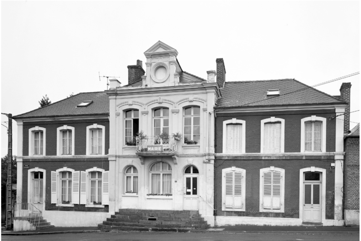
Vue d'ensemble de la façade.
