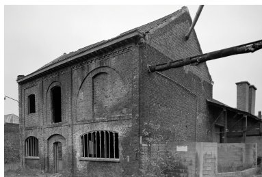
Remise, vue extérieure. Phot. Olivier Marlard IVR31_19885902242X
