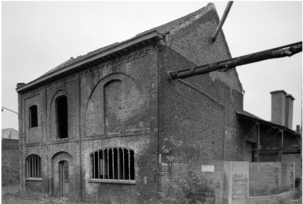
Remise, vue extérieure.
