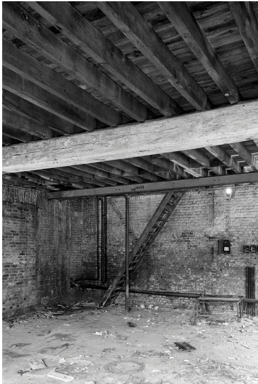
Remise, vue intérieure du rez-de-chaussée.
