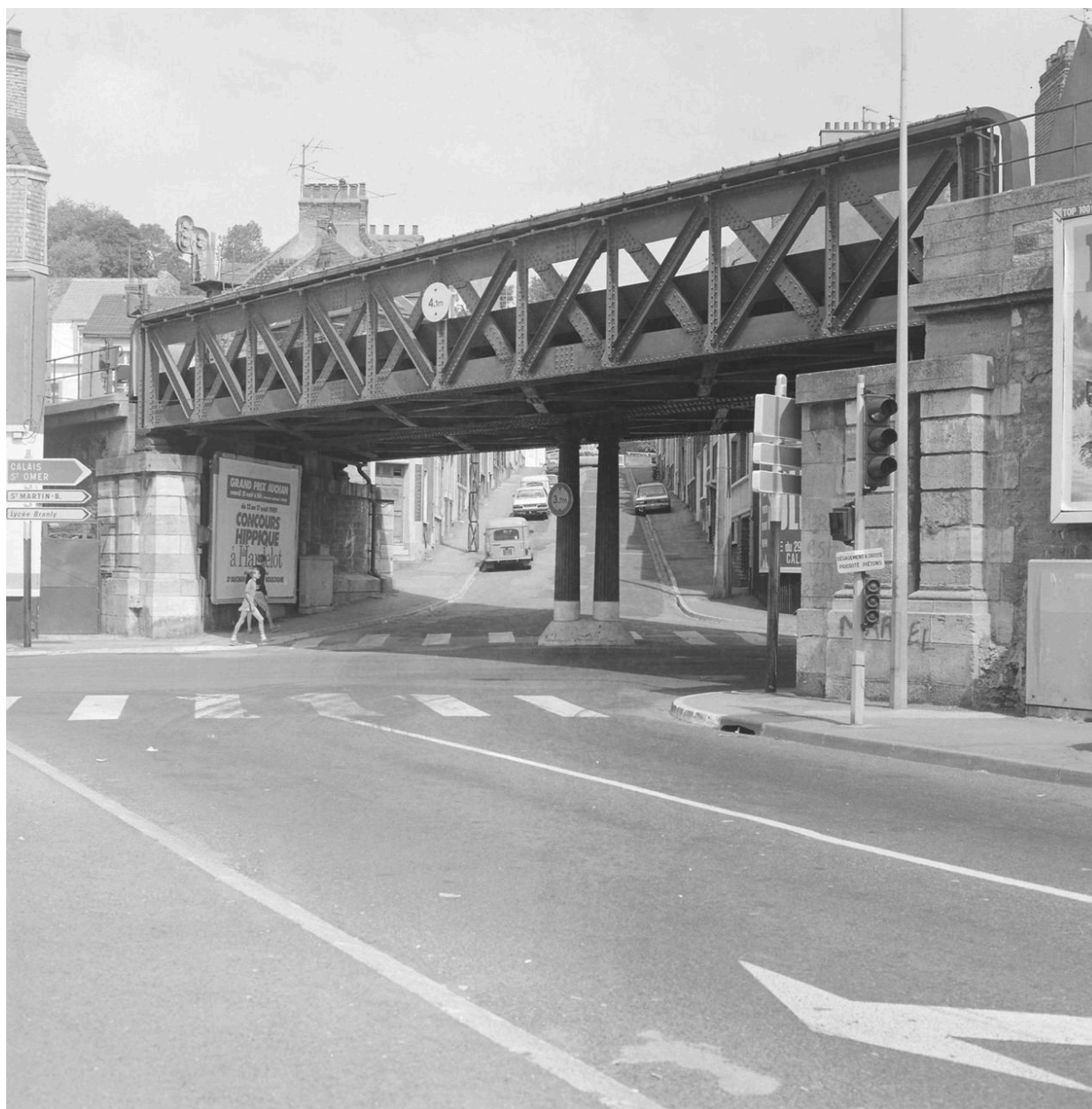
Pont de la voie ferrée Paris-Calais, boulevard Auguste Comte.
