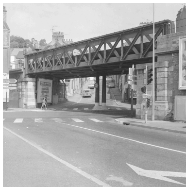
Pont de la voie ferrée Paris- Calais, boulevard Auguste Comte. Phot. Philippe Dapvril
