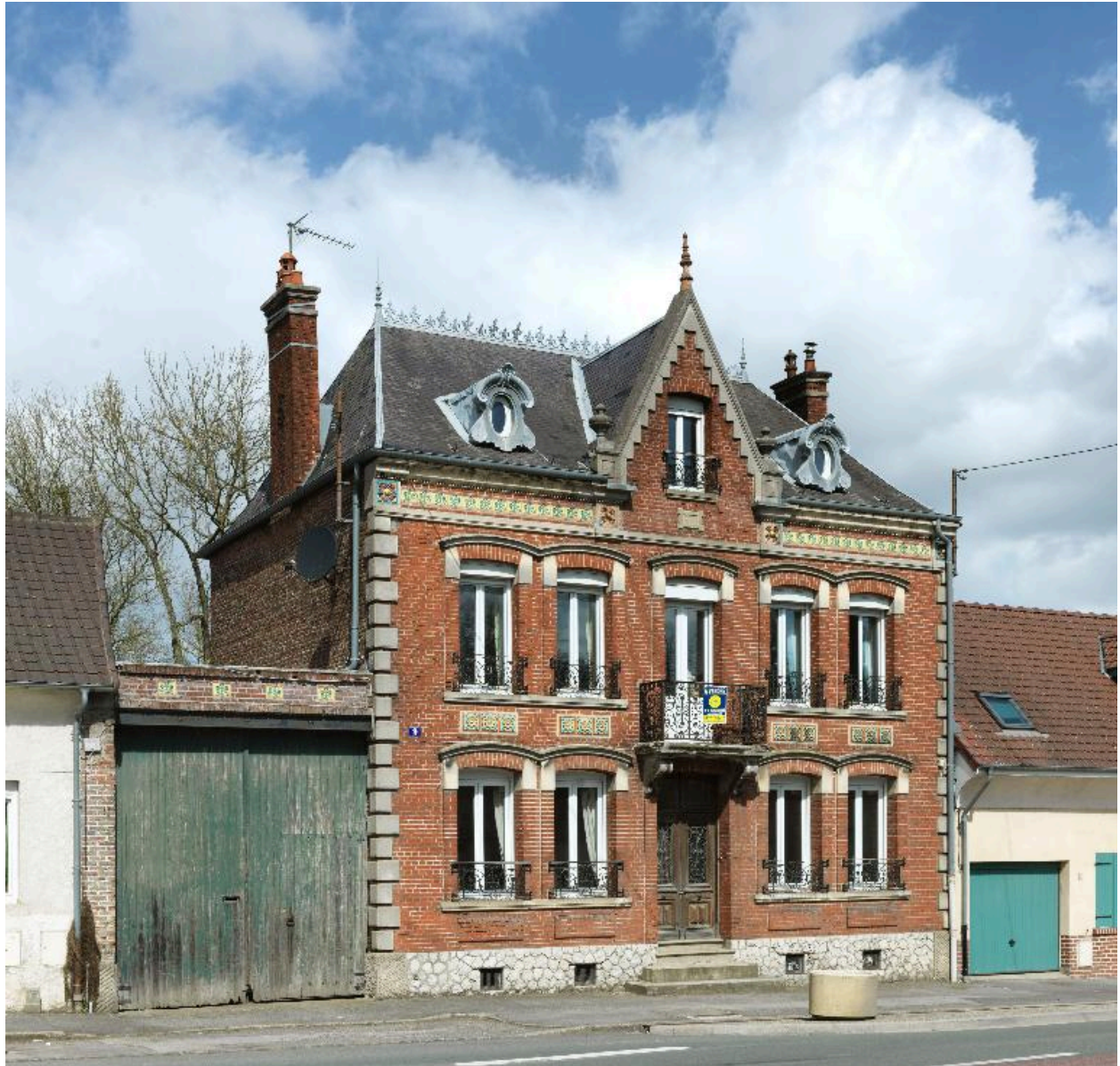
Vue d'ensemble sur rue.
