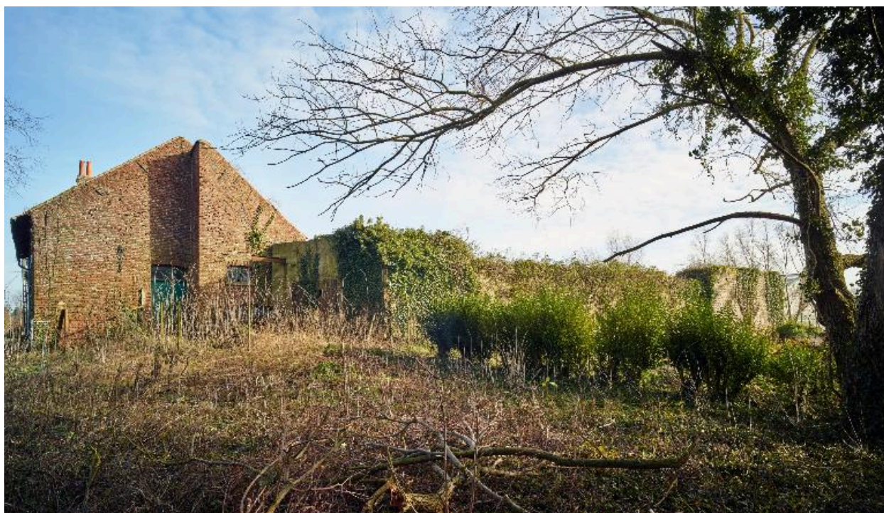
Vue générale de la ferme dont la casemate occupe toute l'aile ouest.
