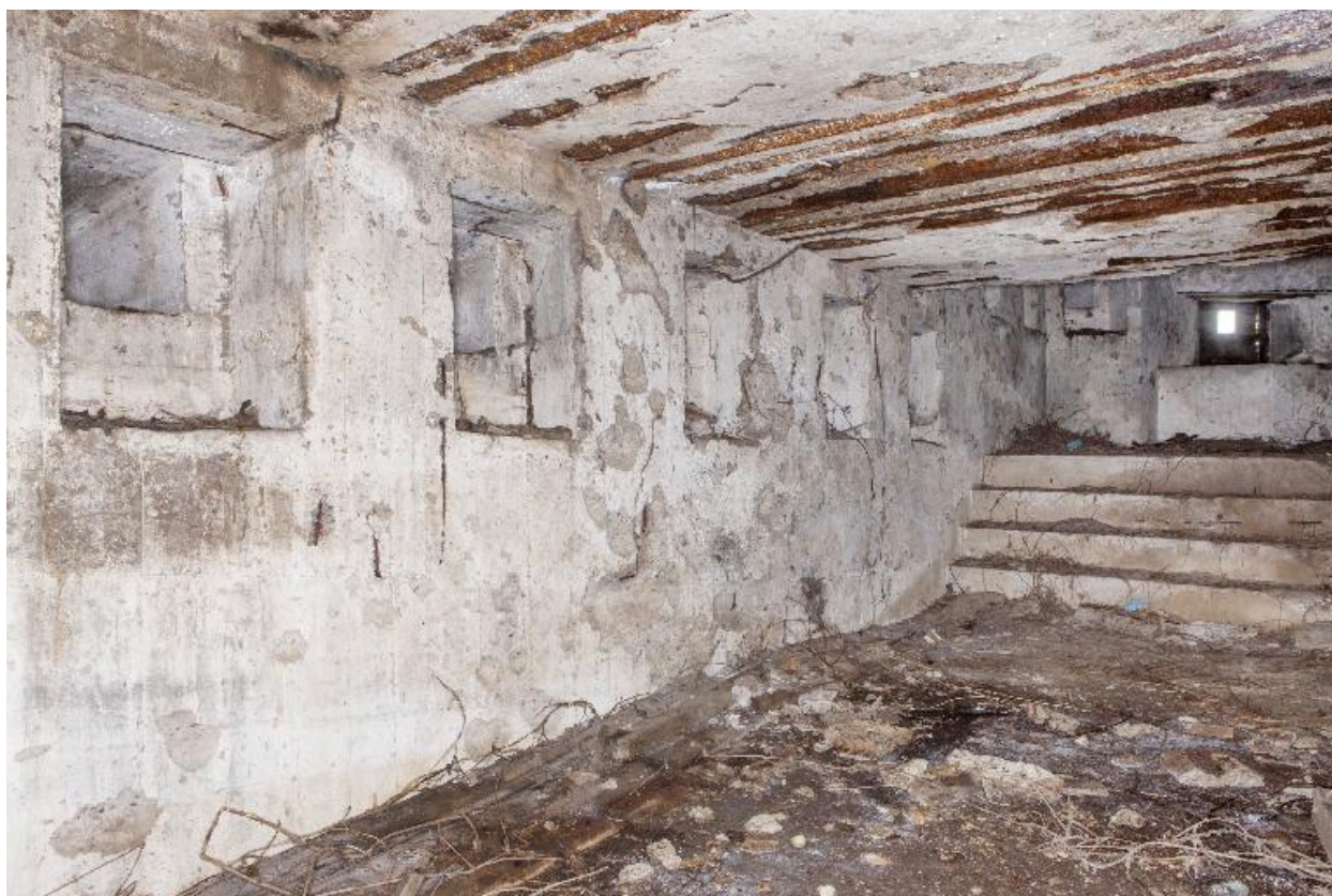
Créneaux de fusillade depuis le niveau intermédiaire vers le premier niveau intermédiaire
