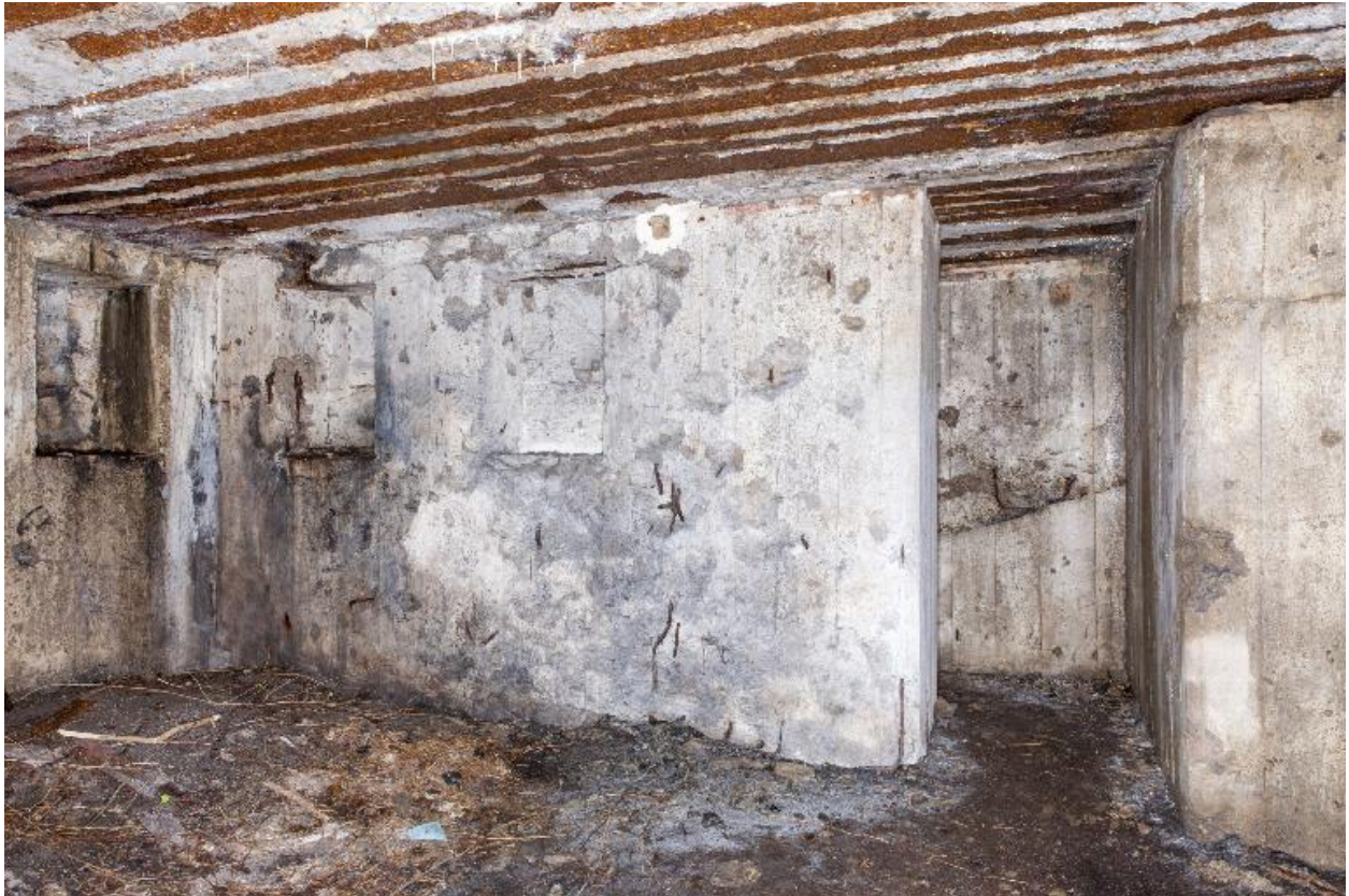
Une des pièces situées au rez-de-chaussée. La porte ouvre sur un petit escalier menant au niveau intermédiaire
