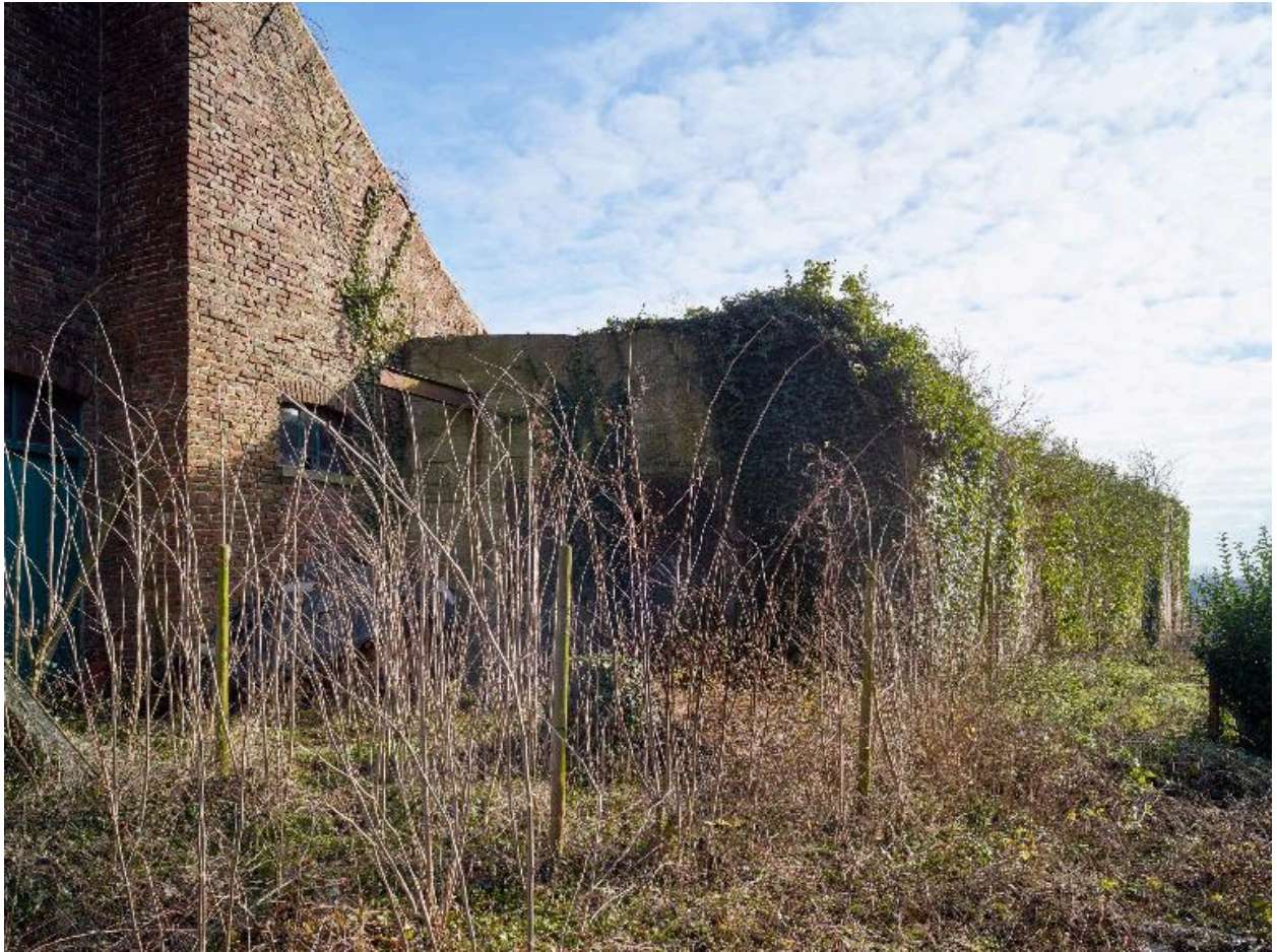
Pignon nord de la casemate, vers le sud-est.
