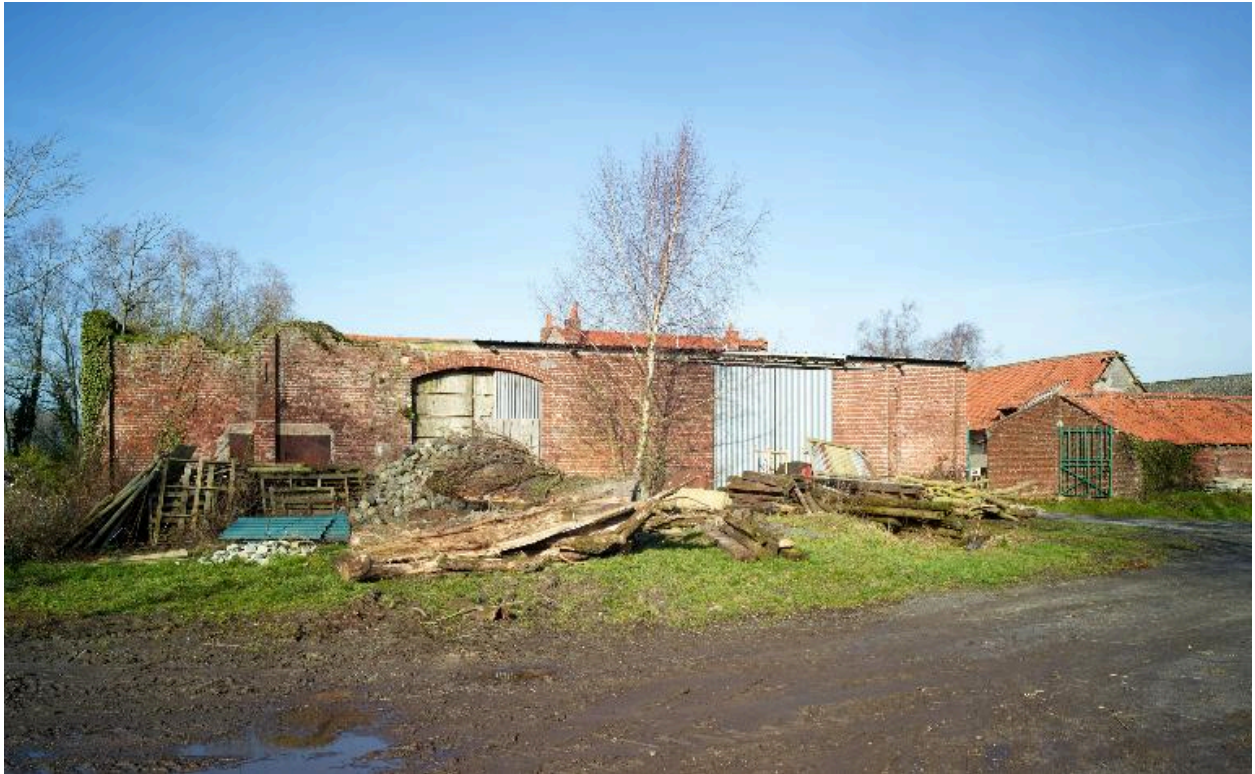
Elévation sud de la ferme. L'extrémité de la casemate apparait au niveau de la porte cochère.
