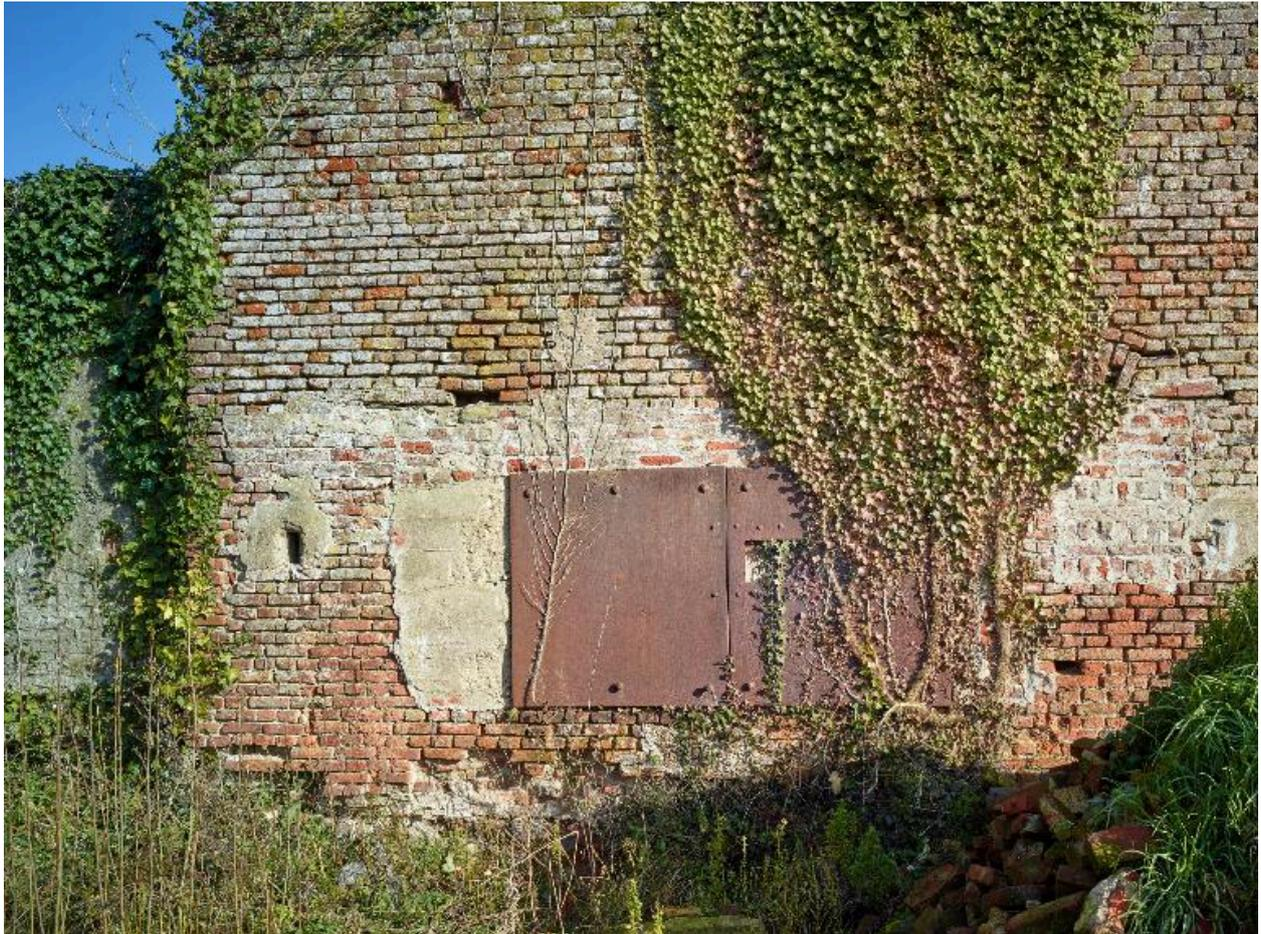
Plaque métallique masquant une ouverture de tir aménagée dans le mur ouest de la ferme, près de l'angle sud.
