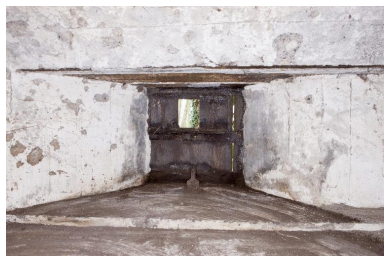
Détail du créneau de fusillade depuis la table de la mitrailleuse au premier niveau de l'édifice Phot. Pierre Thibaut IVR32_20165900016NUCA
