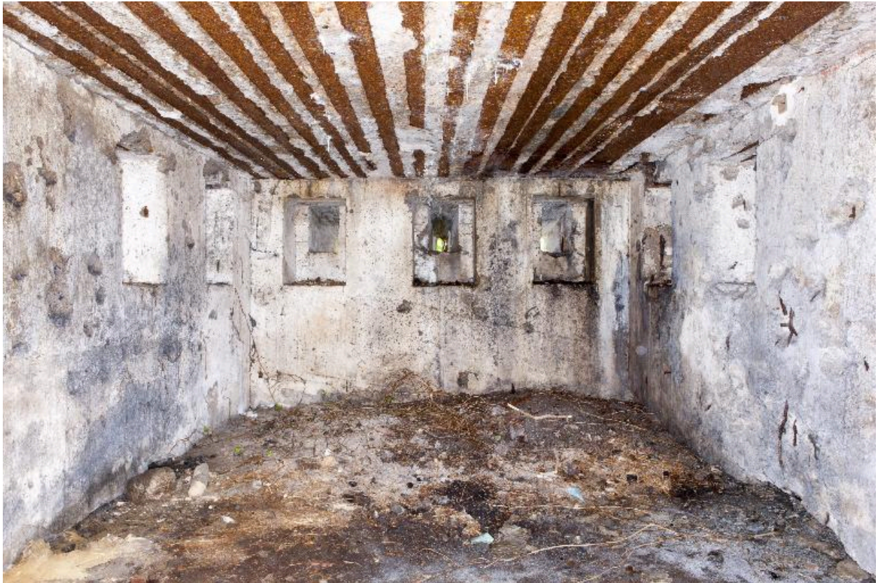
Une des pièces du rez-de-chaussée avec ses créneaux de fusillade
