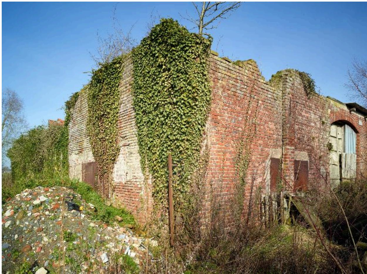
De part et d'autre de l'angle sud de la ferme, deux embrasures de tir (masquées d'une plaque d'acier). A droite, dans l'encadrement de la porte cochère, apparaît un pan de mur de la casemate.
