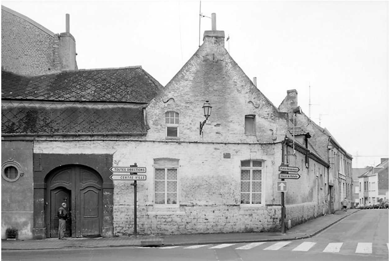
Vue partielle : corps de bâtiment faisant l'angle de la place Verte et de la rue de la Cavalerie (état en 2000).
