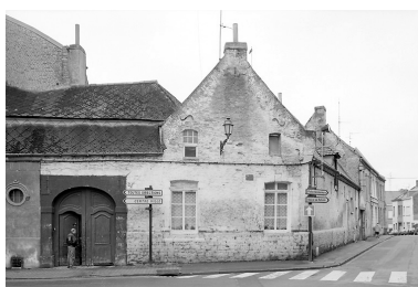
Vue partielle : corps de bâtiment faisant l'angle de la place Verte et de la rue de la Cavalerie (état en 2000).
