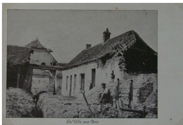
Vue du village pendant les conflits. Phot. Inès Guérin IVR22_20030203154NUCAB
