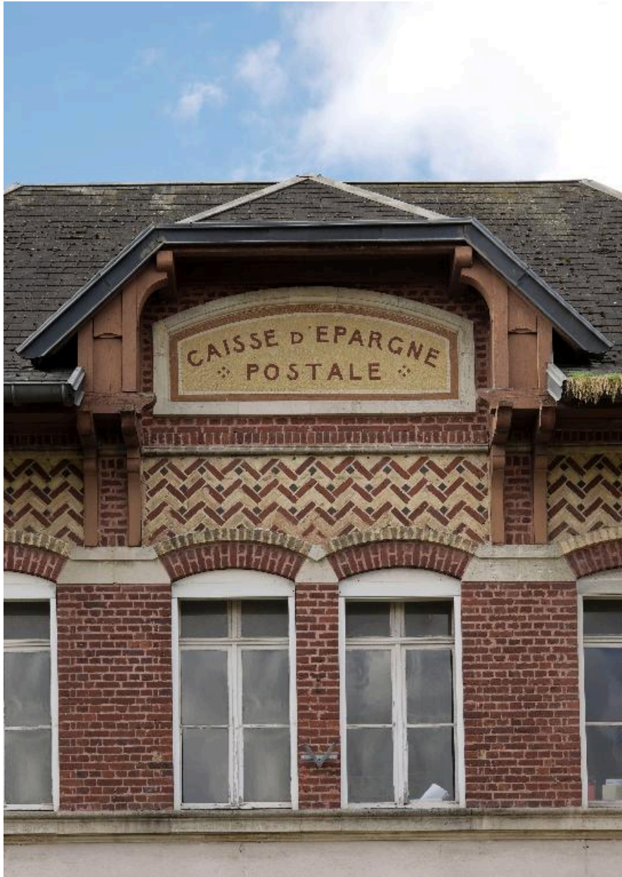
Détail de la partie centrale supérieure de l'élévation sur rue.
