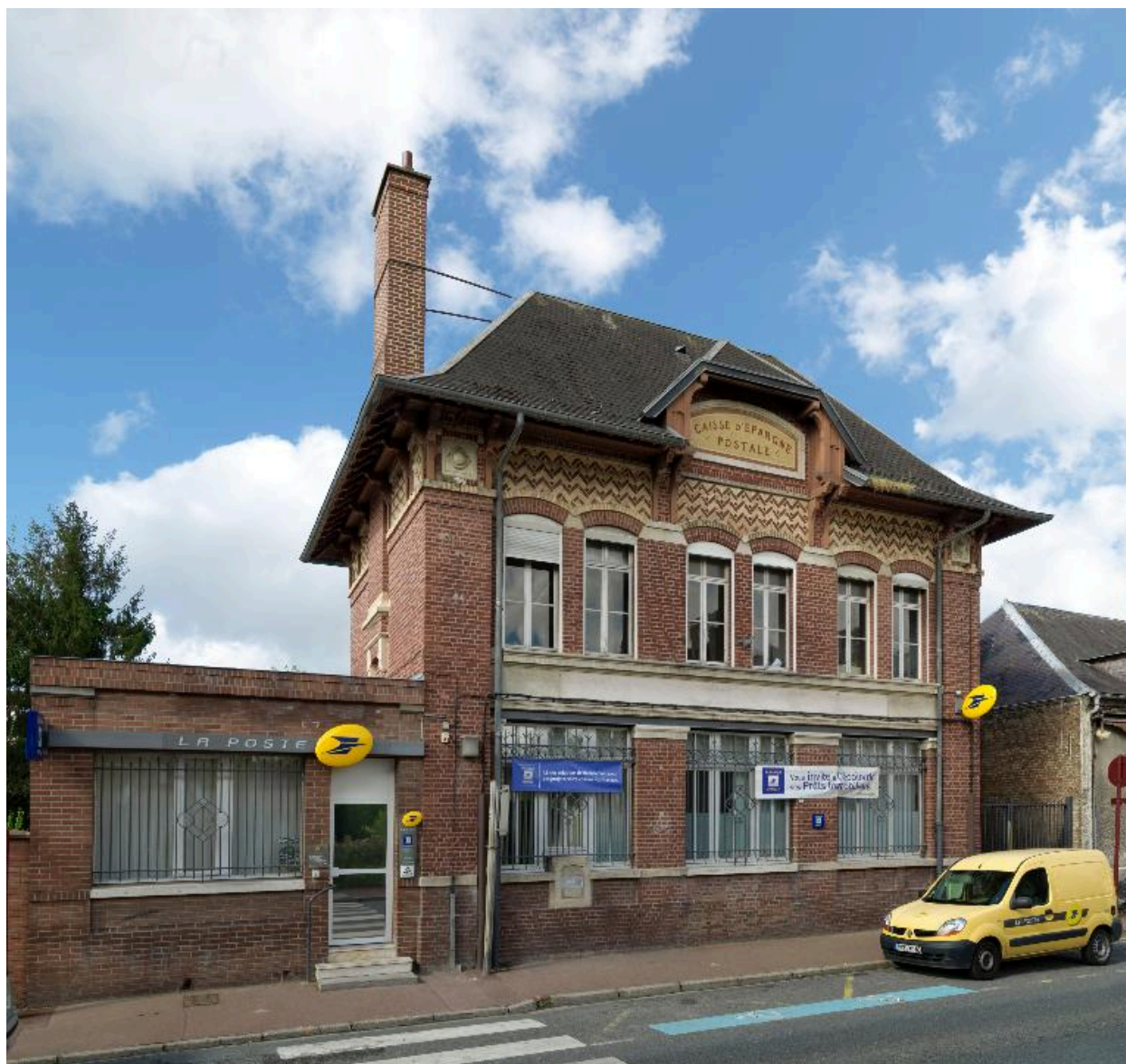
Vue d'ensemble sur rue.
