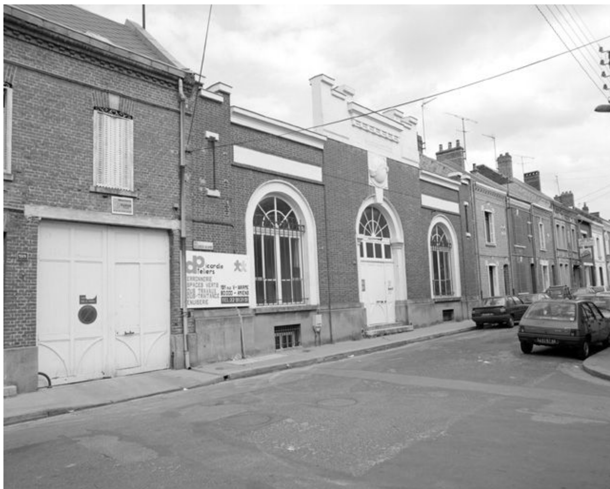
Vue du magasin-réception (élévation antérieure).
