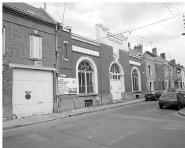
Vue du magasin-réception (élévation antérieure). Phot. Thierry Lefébure IVR22_19898000066X
