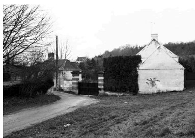
Vue générale de l'entrée de l'usine, avec la conciergerie et le bureau. Phot. Benoît Dufournier IVR22_19936002471Z
