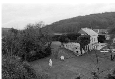
Vue générale. Phot. Benoît Dufournier IVR22_19936002475Z
