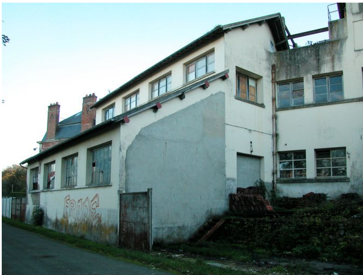
Vue d'ensemble nord-ouest de l'atelier de fabrication et du quai couvert, aujourd'hui muré.
