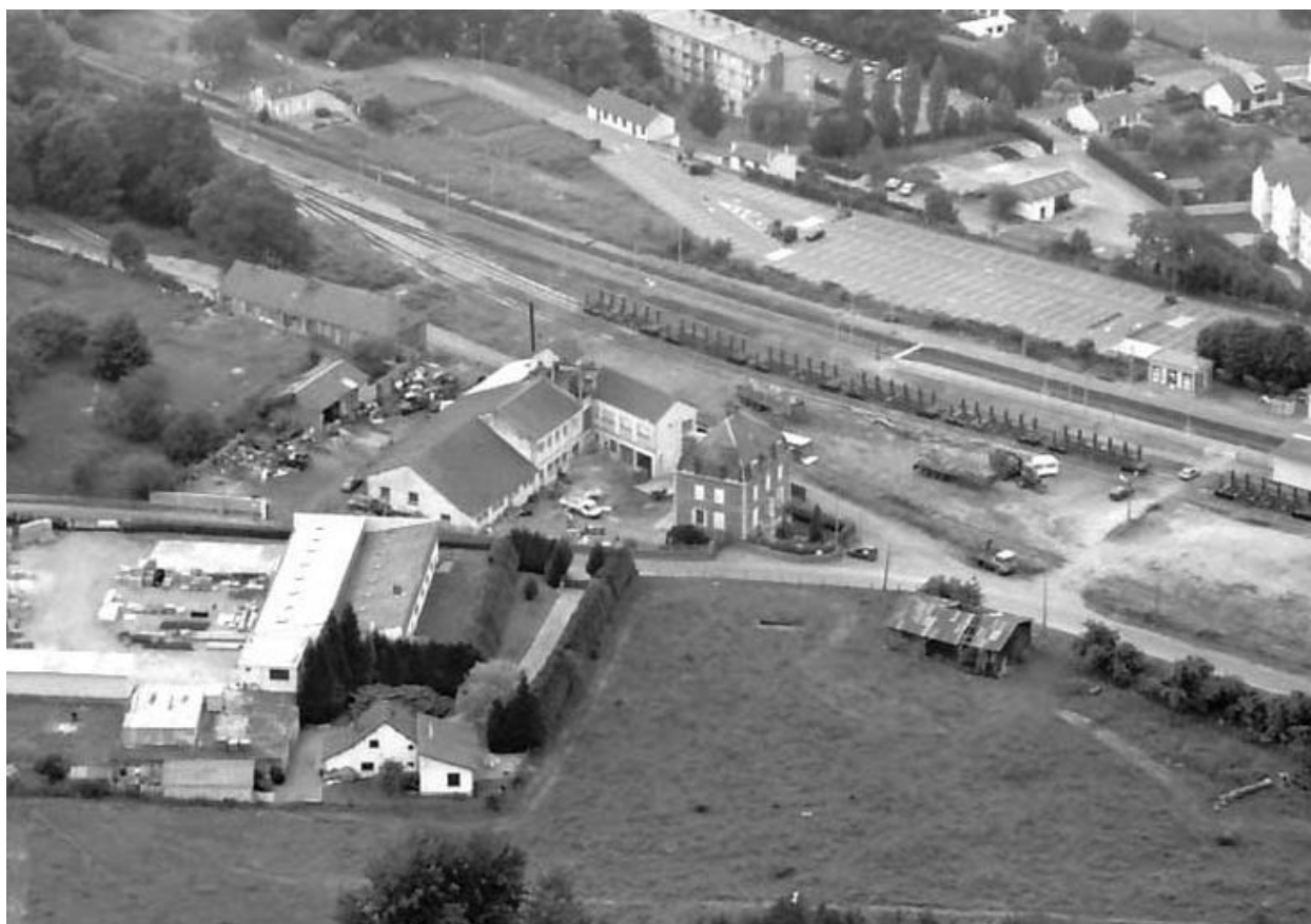
Vue aérienne de la laiterie en 1994.
