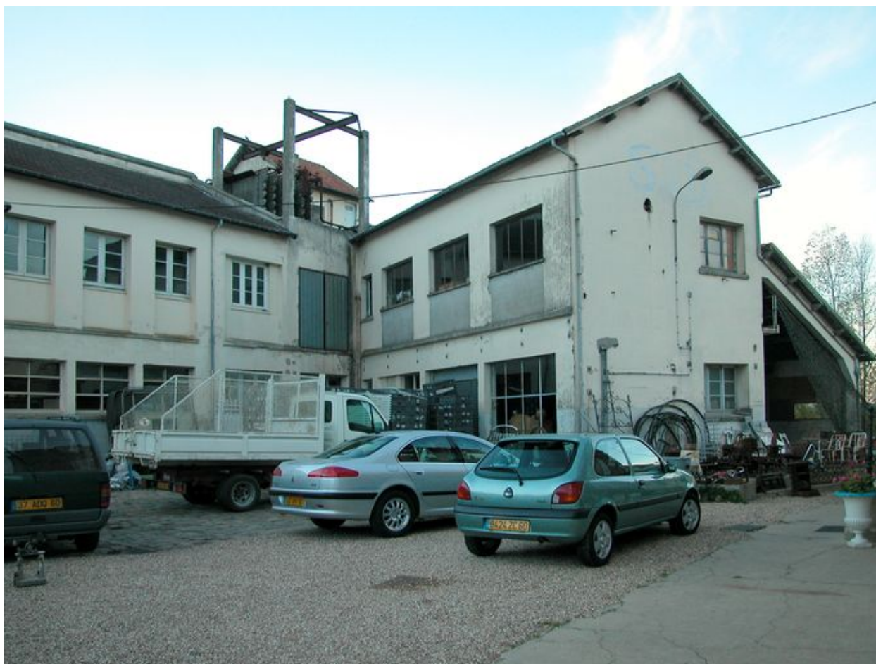
Vue d'ensemble sud-est de la laiterie.
