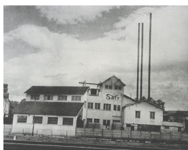
Vue d'ensemble de la laiterie en 1954. Phot. Thierry Lefébure IVR22_20056000247NUCAB
