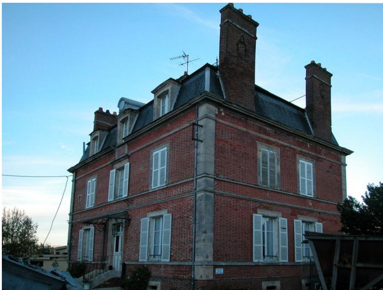
Le logement patronal, vue d'ensemble sud-ouest.
