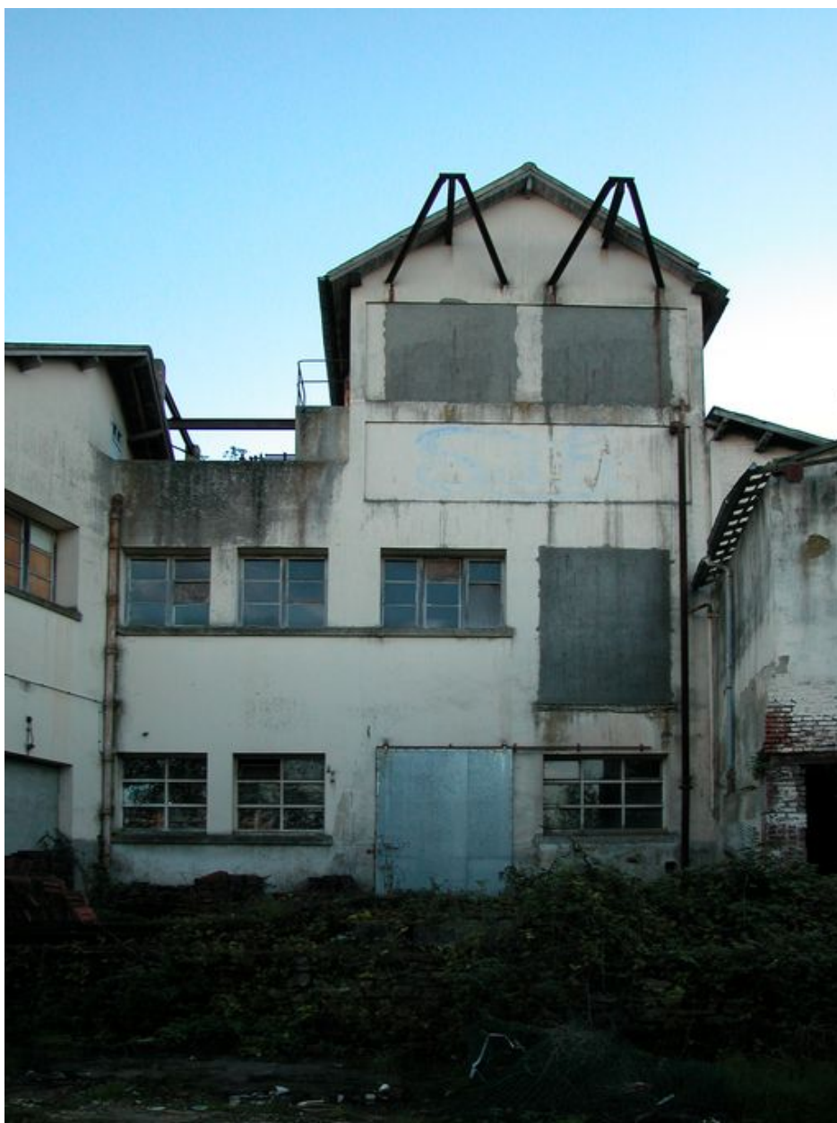
Atelier de fabrication, façade nord.
