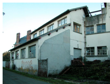
Vue d'ensemble nord-ouest de l'atelier de fabrication et du quai couvert, aujourd'hui muré. Phot. Bertrand Fournier IVR22_20056001410NUCA
