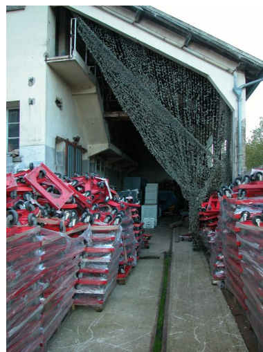
Le quai couvert desservi par un embranchement ferroviaire visible au premier plan. Phot. Bertrand Fournier IVR22_20056001413NUCA
