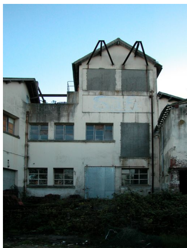
Atelier de fabrication, façade nord. Phot. Bertrand Fournier IVR22_20056001411NUCA
