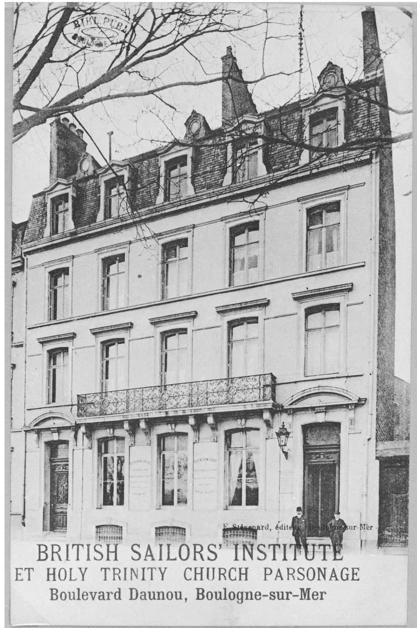
Façade sur voie. B.M. Boulogne-sur-Mer, division cartes postales.
