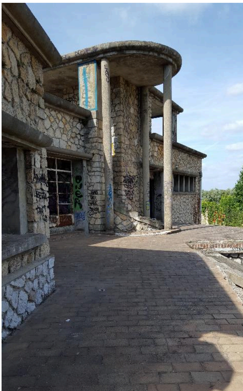
Détail du porche d'entrée de la piscine.
