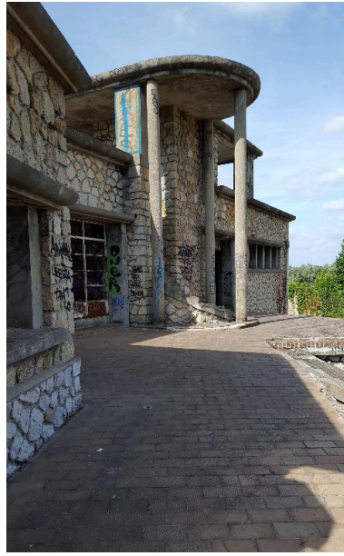
Détail du porche d'entrée de la piscine. Phot. Laurence Schlosser IVR32_20178005078NUCA
