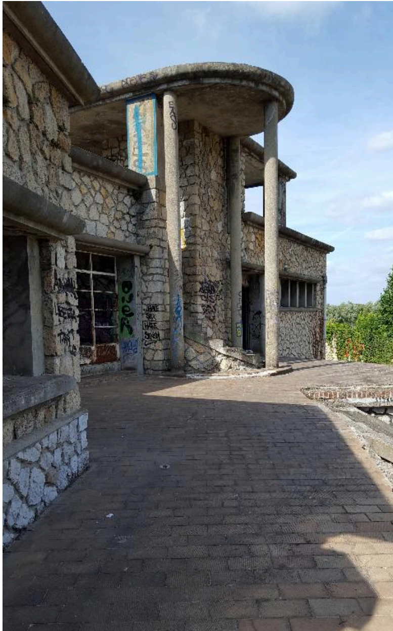
Détail du porche d'entrée de la piscine.
