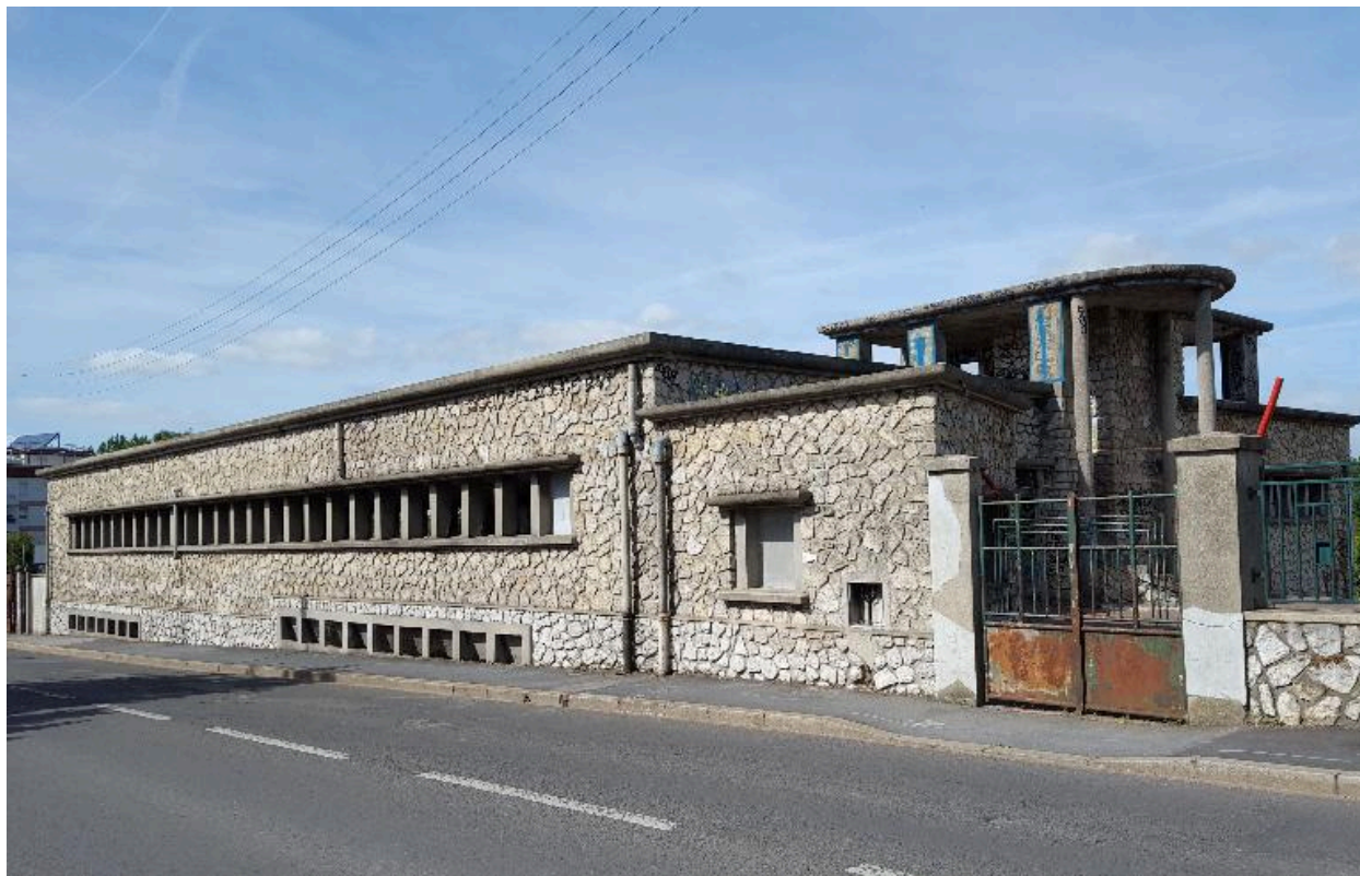
Vue de l'entrée du bâtiment d'accueil de la piscine, depuis la rue Dejean, à l'abandon.
