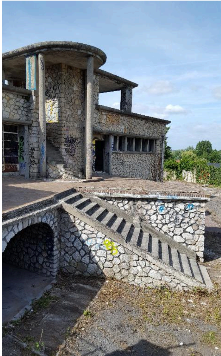
Vue du bâtiment des vestiaires, avec l'escalier descendant vers les bassins.
