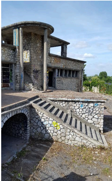
Vue du bâtiment des vestiaires, avec l'escalier descendant vers les bassins. Phot. Laurence Schlosser IVR32_20178005076NUCA
