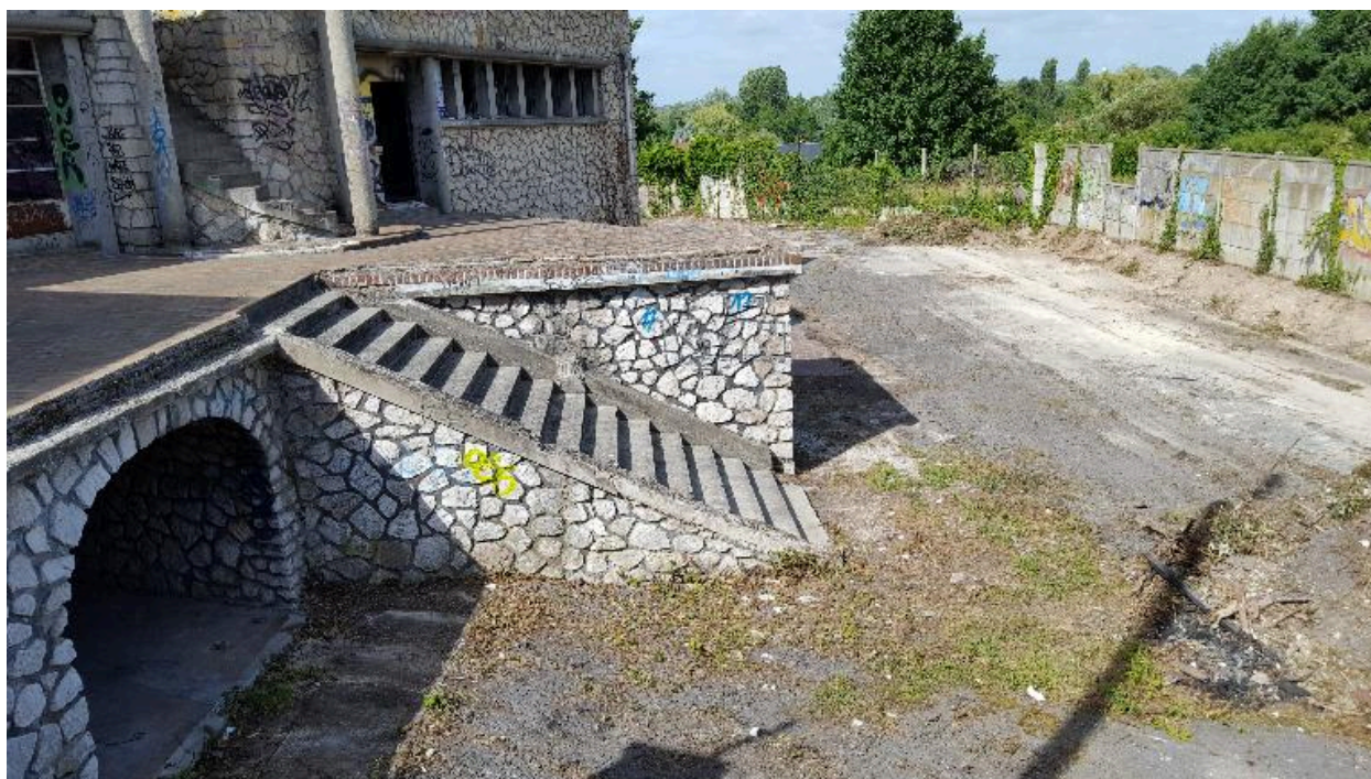
Détail de l'escalier descendant vers les bassins.
