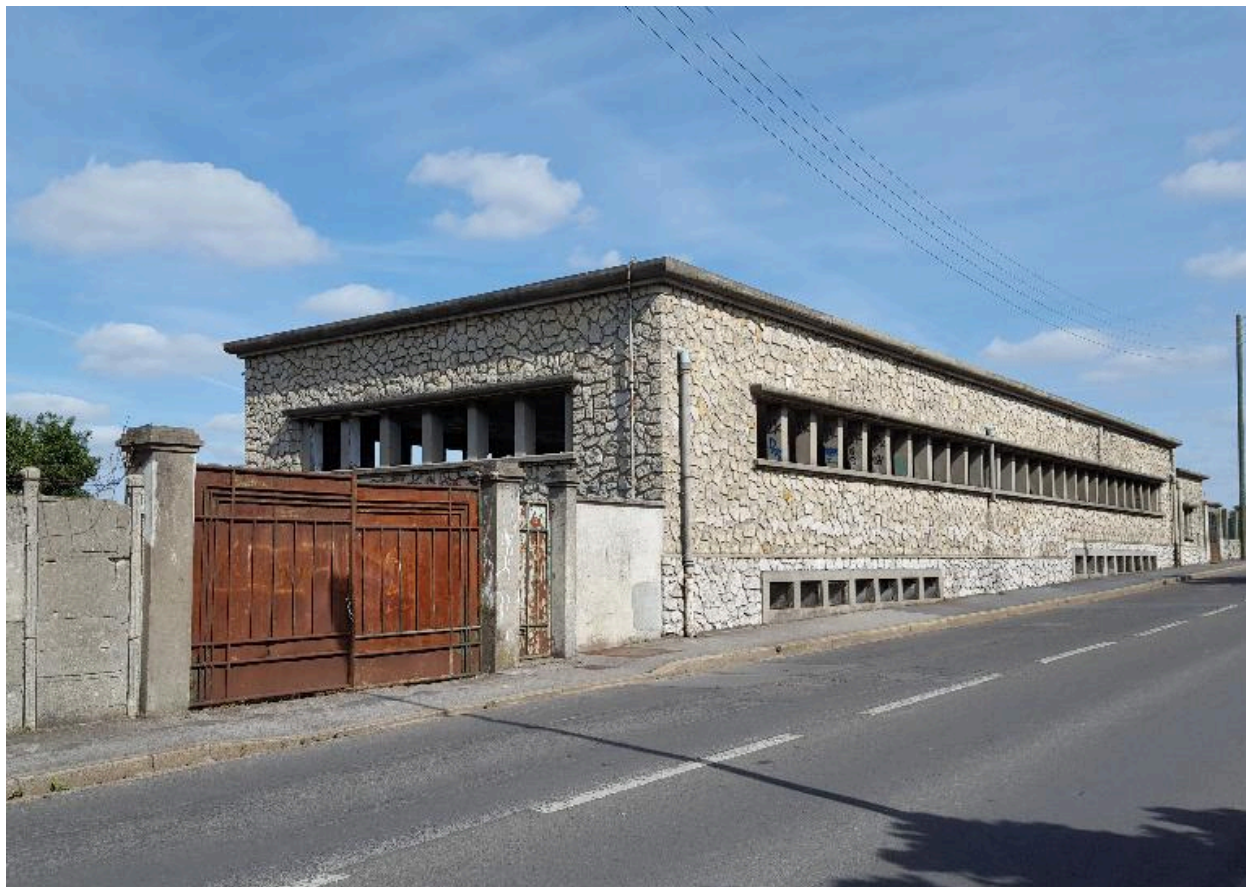
Vue de l'arrière du bâtiment des vestiaires de la piscine depuis la rue Dejean, à l'abandon en juin 2017.
