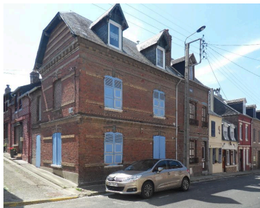
Logement de contremaître. Phot. Isabelle Barbedor IVR22_20158006714NUCA
