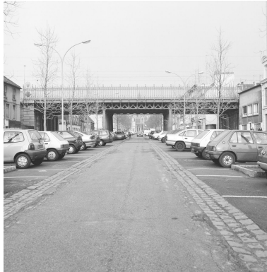
Vue générale. Phot. Philippe Dapvril IVR31_19966200204X
