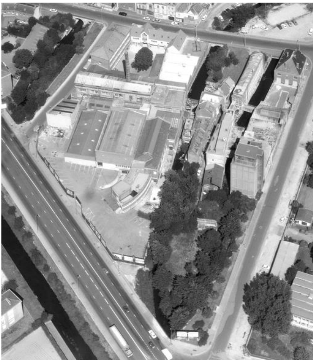
Vue aérienne, depuis l'ouest.
