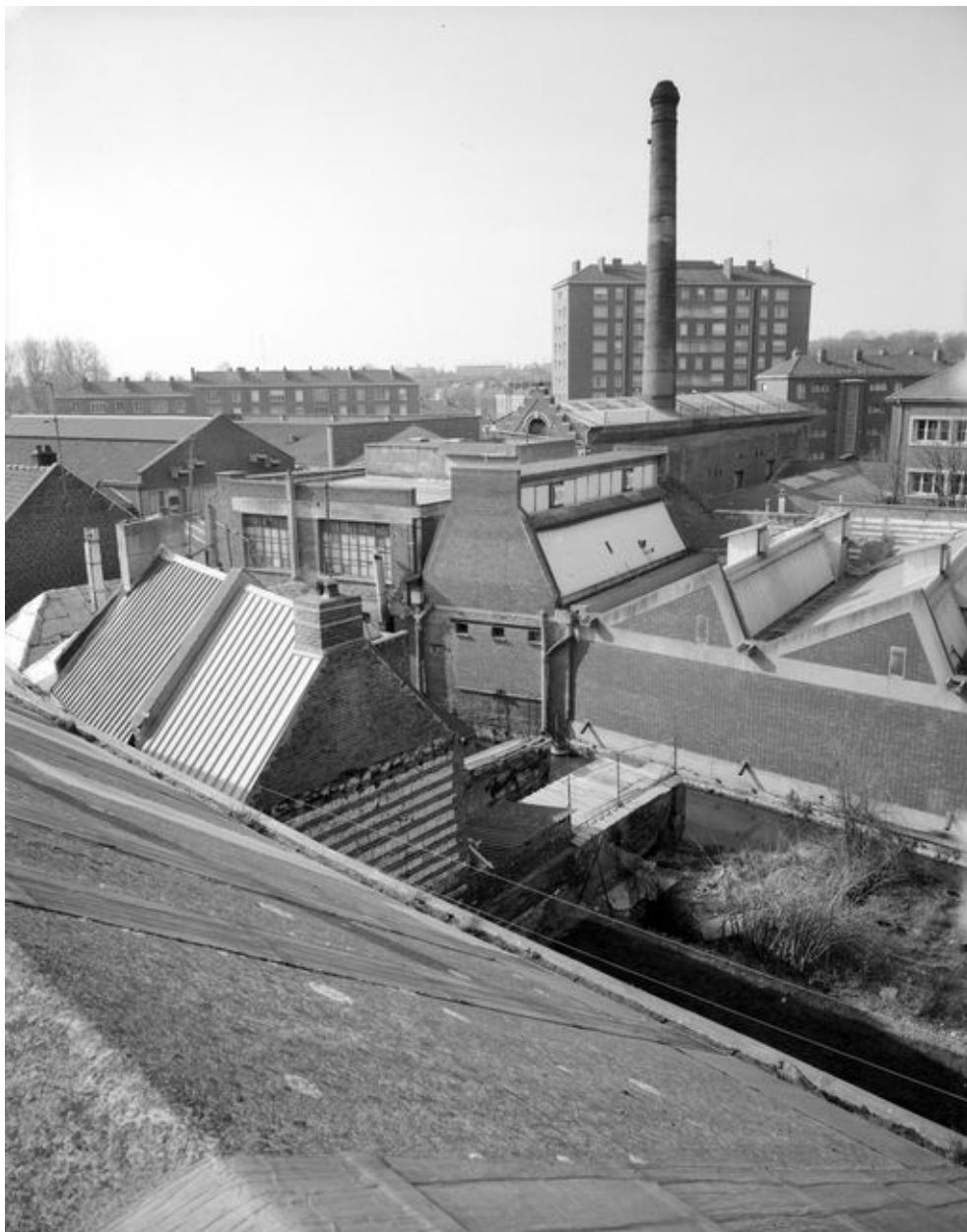
Vue partielle flanc sud-ouest.
