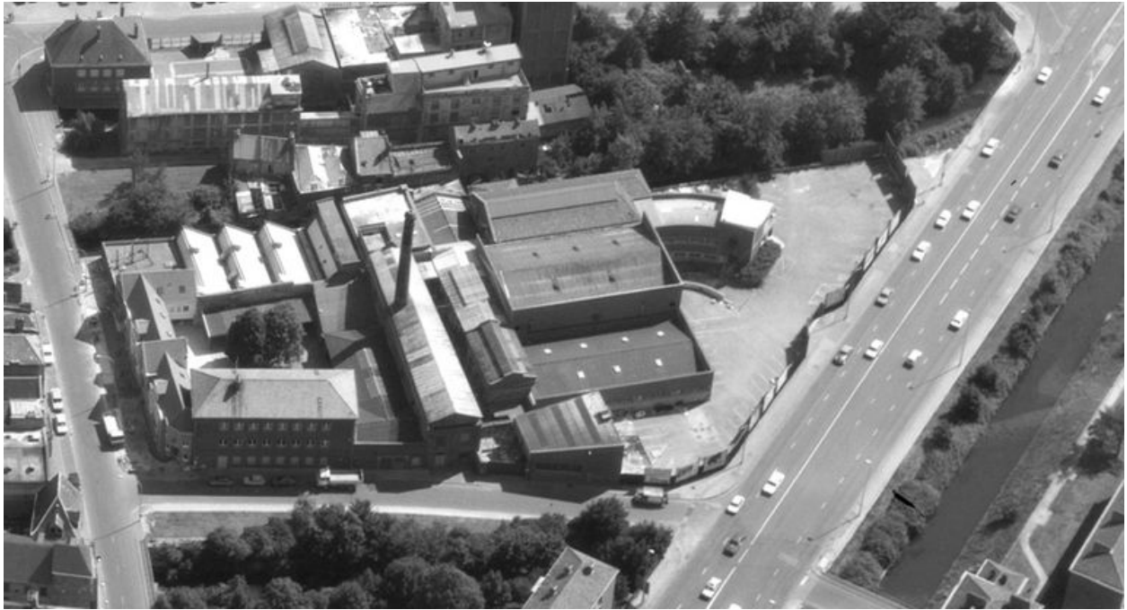
Vue aérienne, depuis le nord.
