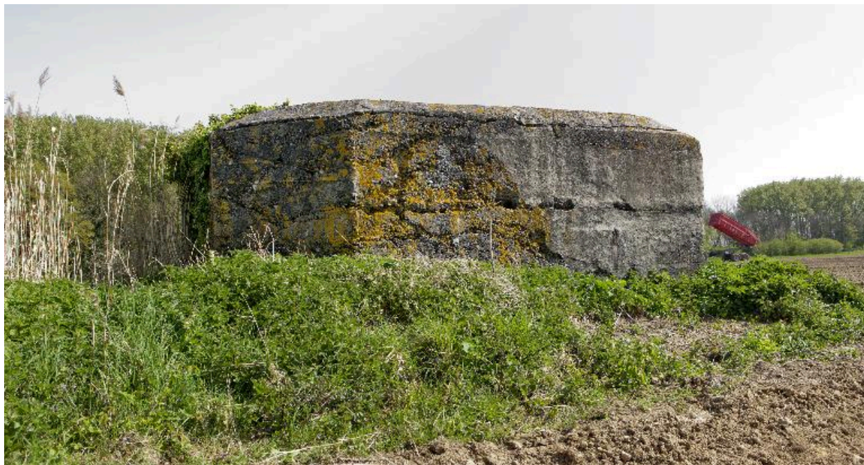
Vue latérale vers le nord-est
