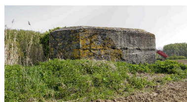
Vue latérale vers le nord-est Phot. Jean-Marc Ramette IVR31_20145904813NUCA
