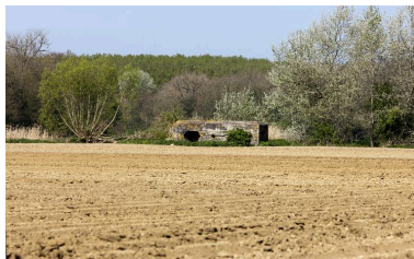
Vue générale vers le nord-ouest Phot. Jean-Marc Ramette IVR31_20145904809NUCA
