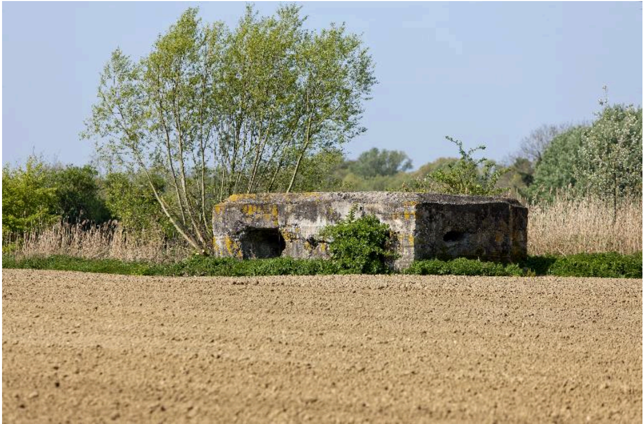
Vue générale vers le nord-ouest
