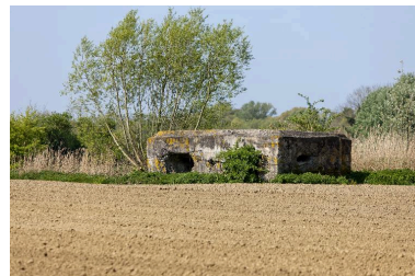
Vue générale vers le nord-ouest Phot. Jean-Marc Ramette IVR31_20145904812NUCA
