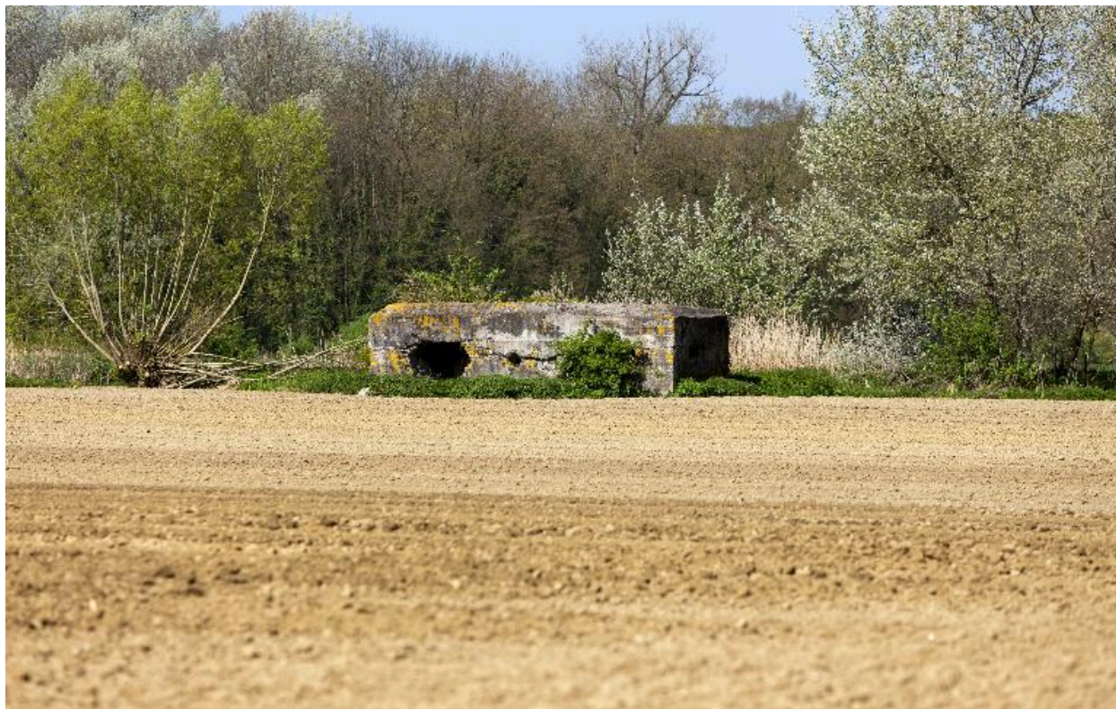
Vue générale vers le nord-ouest
