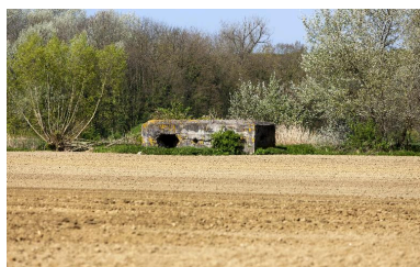
Vue générale vers le nord-ouest Phot. Jean-Marc Ramette IVR31_20145904810NUCA
