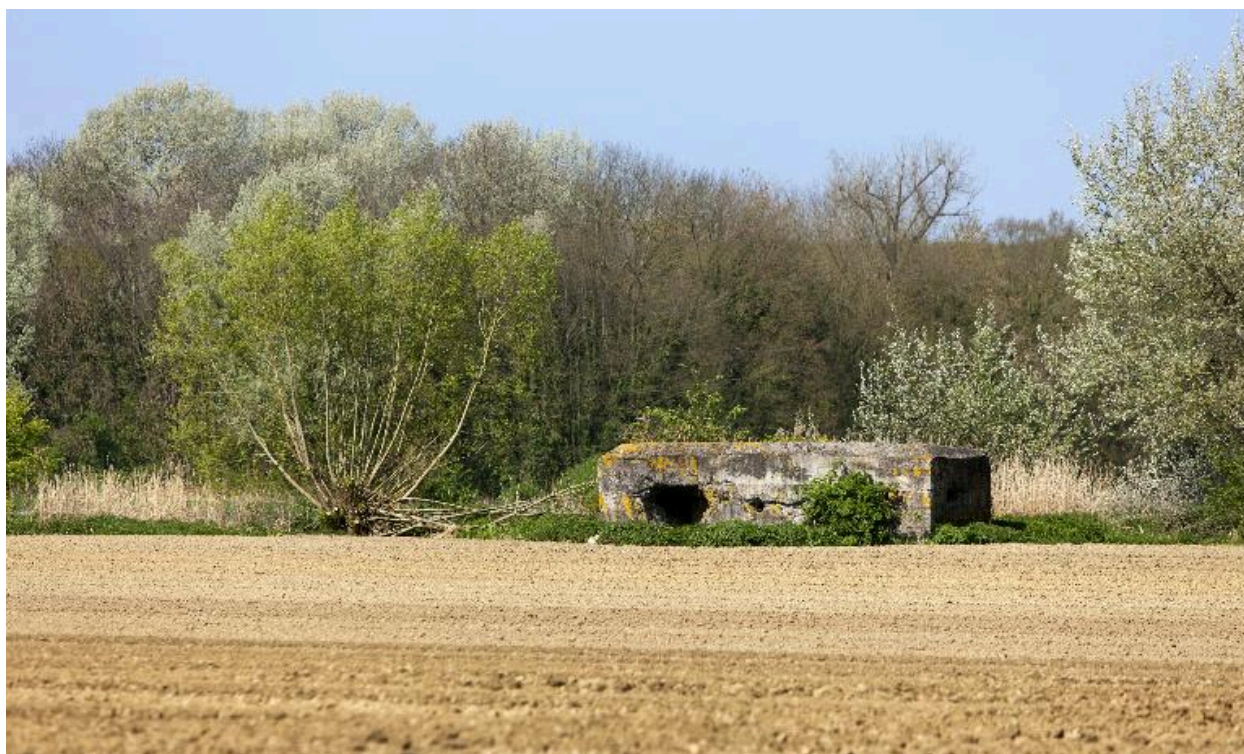
Vue générale vers le nord-ouest
