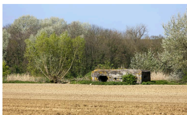
Vue générale vers le nord-ouest Phot. Jean-Marc Ramette IVR31_20145904811NUCA
