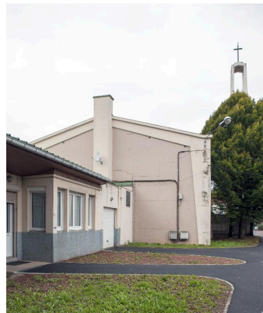
Vue du chevet de l'église et du presbytère.
