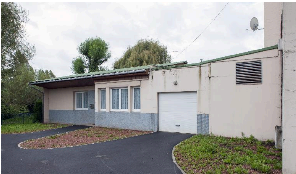
Presbytère situé contre le chevet de l'église.
