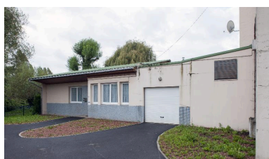
Presbytère situé contre le chevet de l'église.
