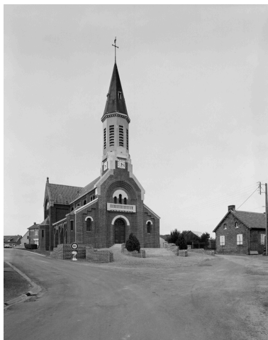
Vue d'ensemble depuis le sud. Phot. Thierry Lefébure IVR22_19910201975V
