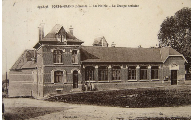
Vue de la maison occupant la fonction de mairie à Port-le-Grand jusqu'au début du 20e siècle. Phot. Inès Guérin IVR22_20068005381NUCAB
