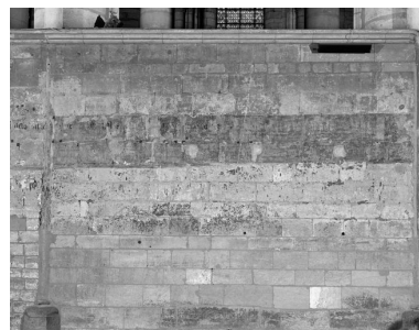
Décor de la travée droite du mur de clôture nord. Phot. Thierry Lefébure IVR22_20010202813V
