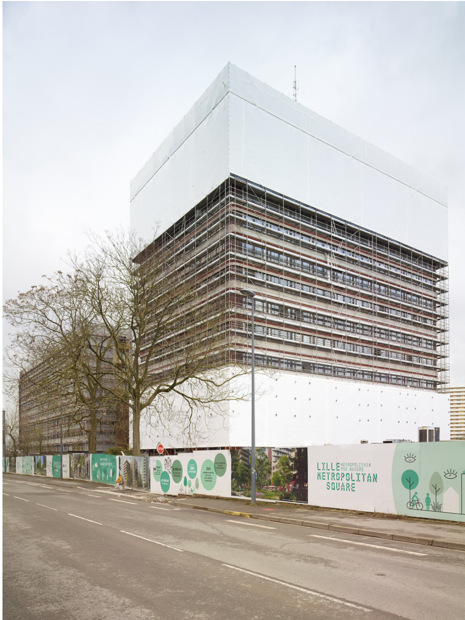
La tour dite R 4 en cours de démolition, depuis la rue du Ballon.
