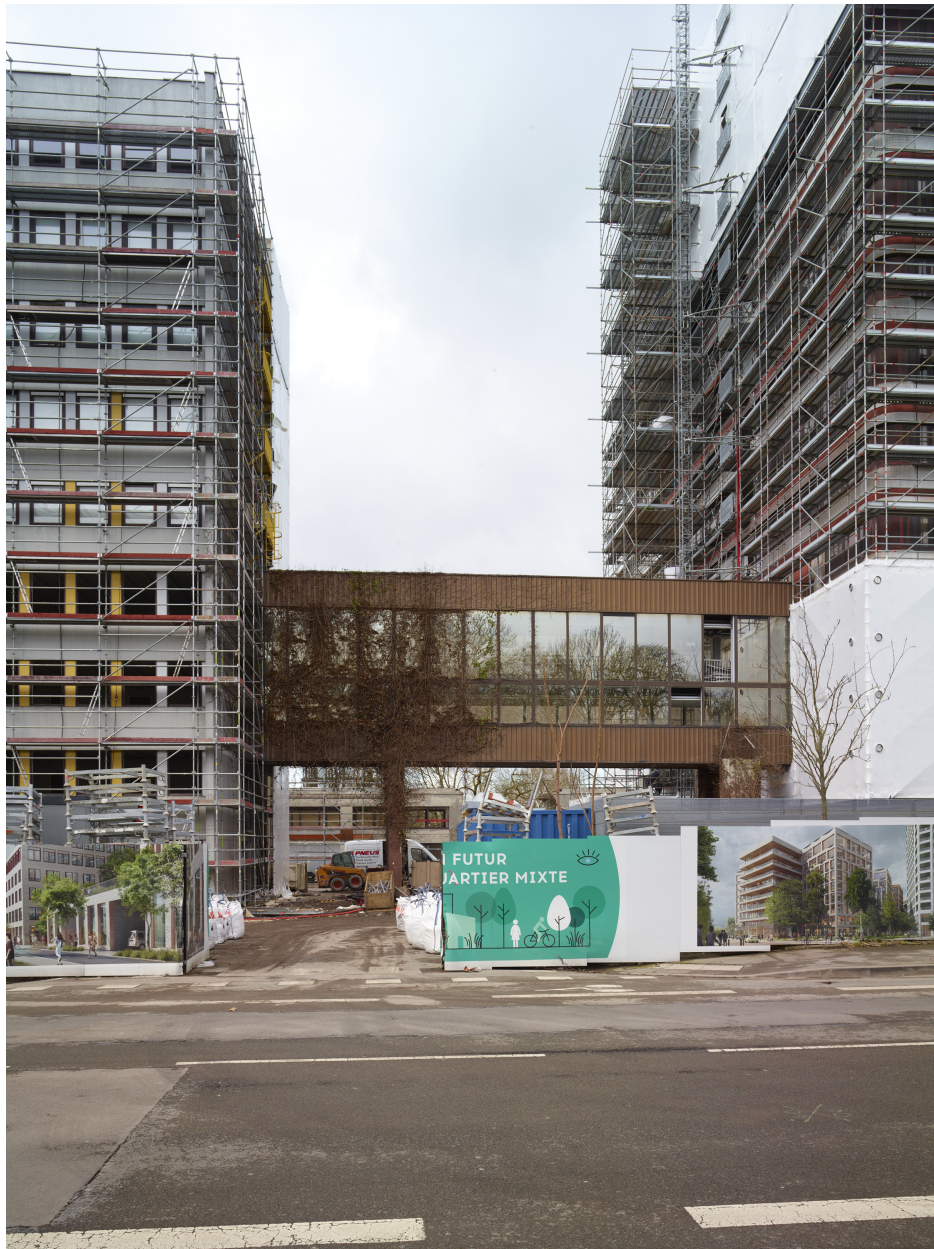
Détail de la passerelle est, vue depuis la rue du Ballon.
