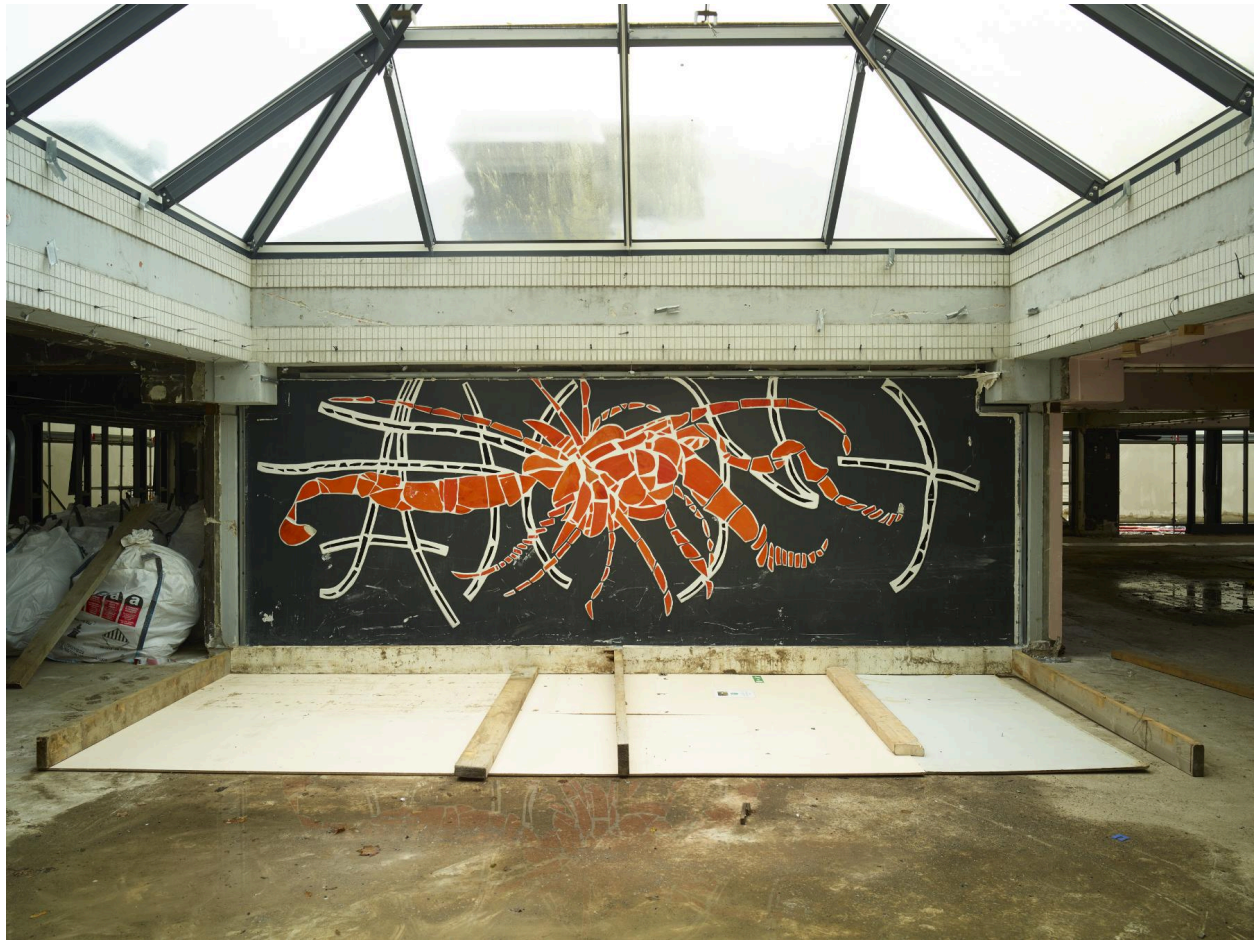
L'œuvre murale Le Homard d'Arthur Van Hecke (1924-2003), après le début des travaux.
