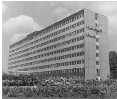
L'hôtel communautaire (CUDL) (bâtiment R8 et entrée) depuis le sud-ouest, avant 1974. On distingue très bien les bacs LUNA surmontant l'entrée, à gauche (Archives communautaires. Métropole européenne de Lille ; 11 Ph 261 n° 6). Repro. Pierre Thibaut IVR32_20245900566NUCA
