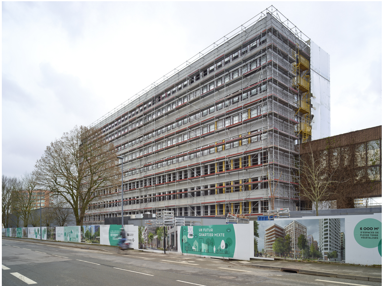
Le bâtiment provisoire dit R8 en cours de démolition, depuis la rue du Ballon.
