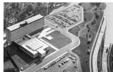
Vue aérienne de l'hôtel communautaire (CUDL), bâtiments provisoires, depuis le nord-ouest (Archives communautaires. Métropole européenne de Lille ; 11 Ph 261 n° 2). Repro. Pierre Thibaut IVR32_20245900564NUCA
