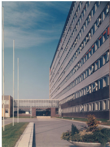
L'entrée de l'hôtel communautaire (CUDL) (bâtiments provisoires) avant 1974. A droite le bâtiment R8 (Archives communautaires. Métropole européenne de Lille ; 11 Ph 261 n° 1). Repro. Pierre Thibaut IVR32_20245900563NUCA
