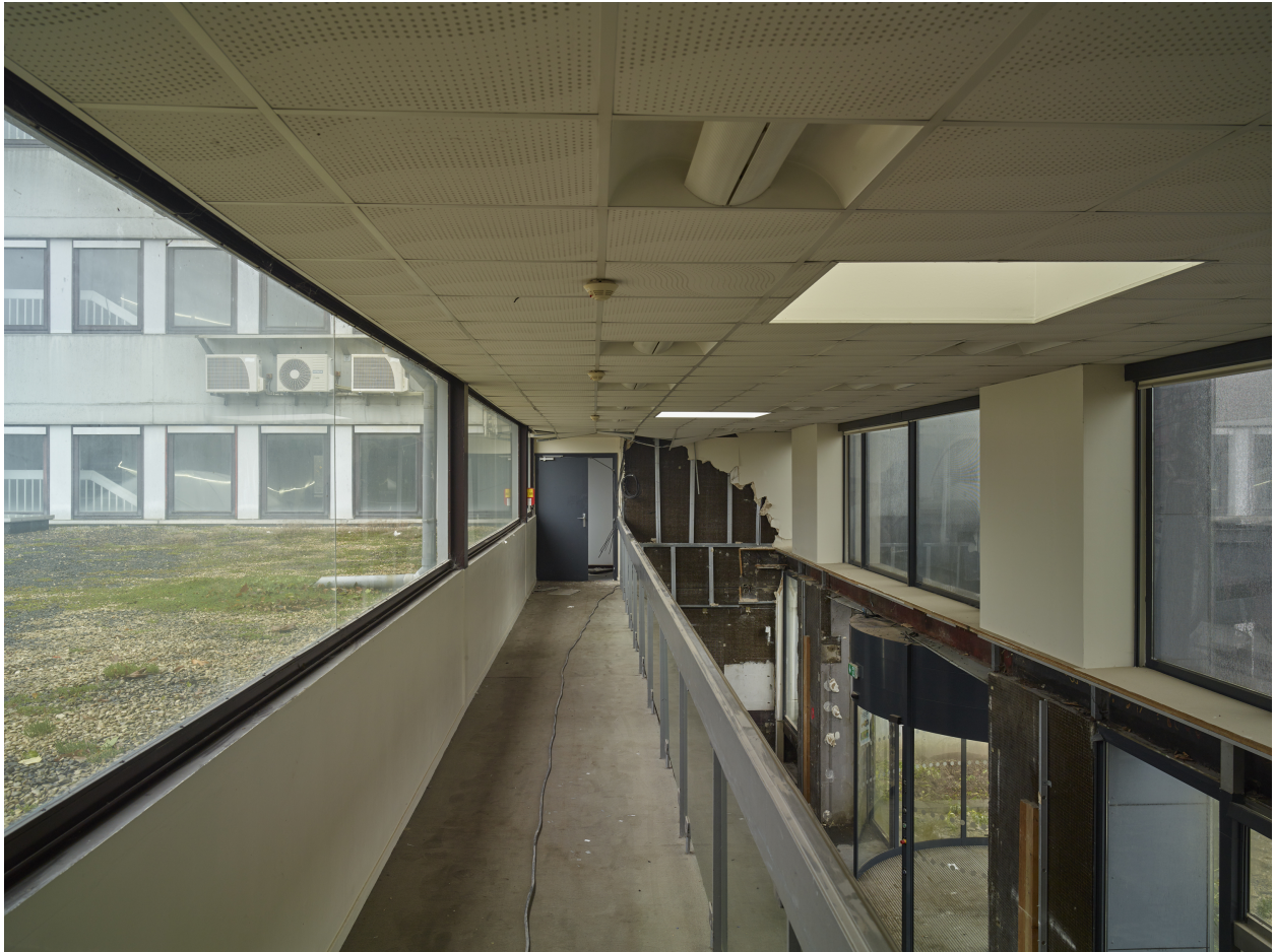
Bâtiment d'entrée : vue de la galerie supérieure, reliant le bâtiment administratif R8 (au fond) au bâtiment du Conseil. En bas à droite l'entrée du public.
