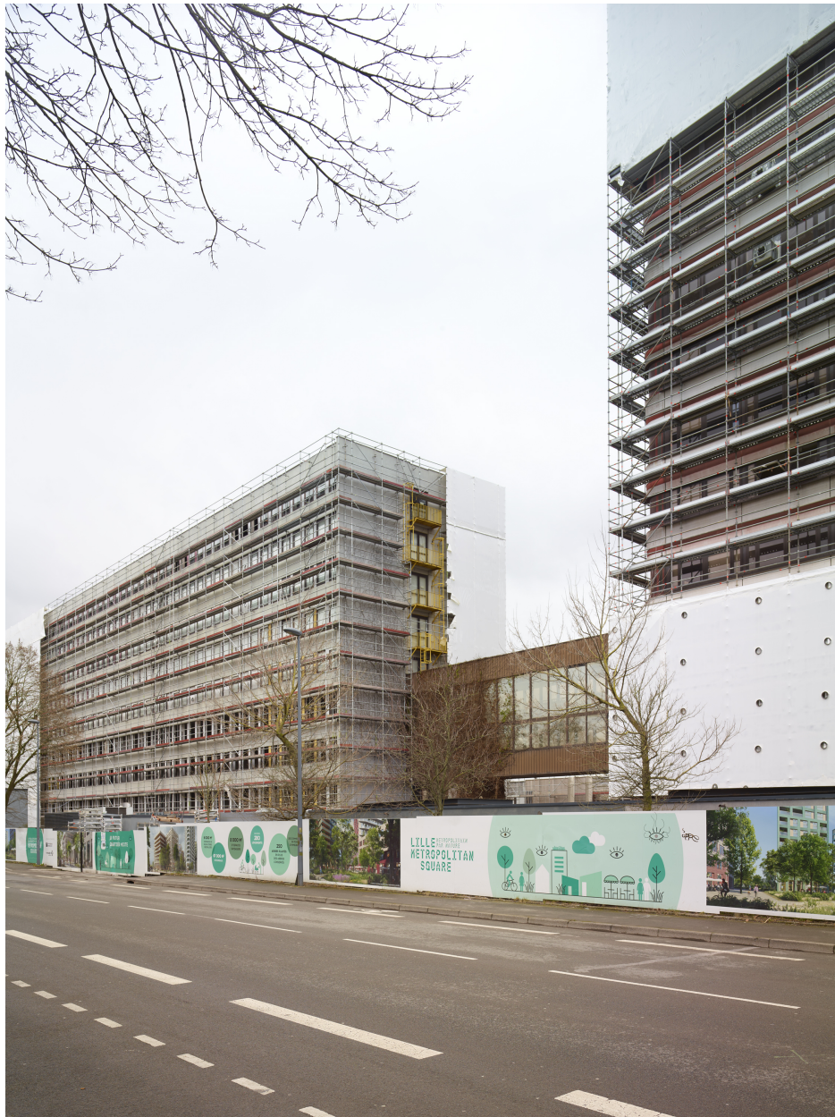
Vue générale vers le sud, depuis la rue du Ballon, en cours de démolition.
