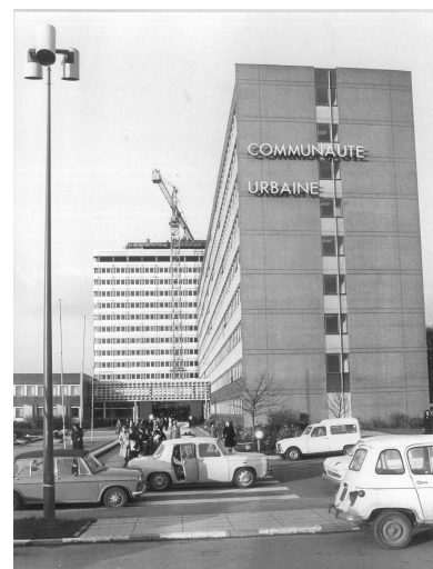
L'entrée de l'hôtel communautaire (CUDL) à la fin des travaux d'extension, depuis la rue de la communauté au sud ; la tour clôt désormais la perspective. Métropole européenne de Lille ; 11 Ph 261 n° 27). Repro. Pierre Thibaut
