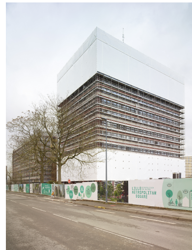
La tour dite R 4 en cours de démolition, depuis la rue du Ballon.
