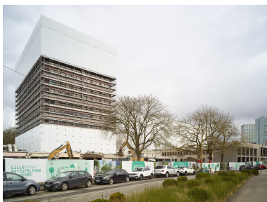
Vue générale depuis l'ouest, en cours de démolition.
