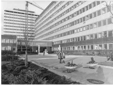
L'hôtel communautaire (CUDL) à la fin des travaux d'extension, depuis le parvis au sud. On distingue très bien les bacs LUNA surmontant l'entrée (Métropole européenne de Lille ; 11 Ph 261 n° 25).
