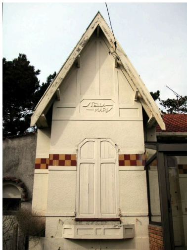
Détail de la travée de gauche en avancée. Phot. Elisabeth Justome IVR22_20058002774NUCA
