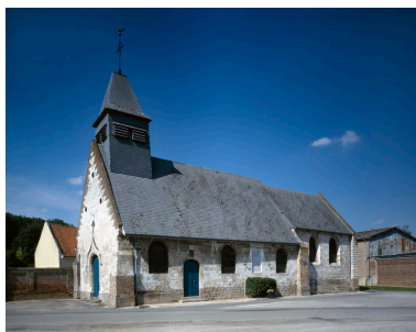
L'église Saint-Firmin. Phot. Irwin Leullier IVR22_19988001129VA
