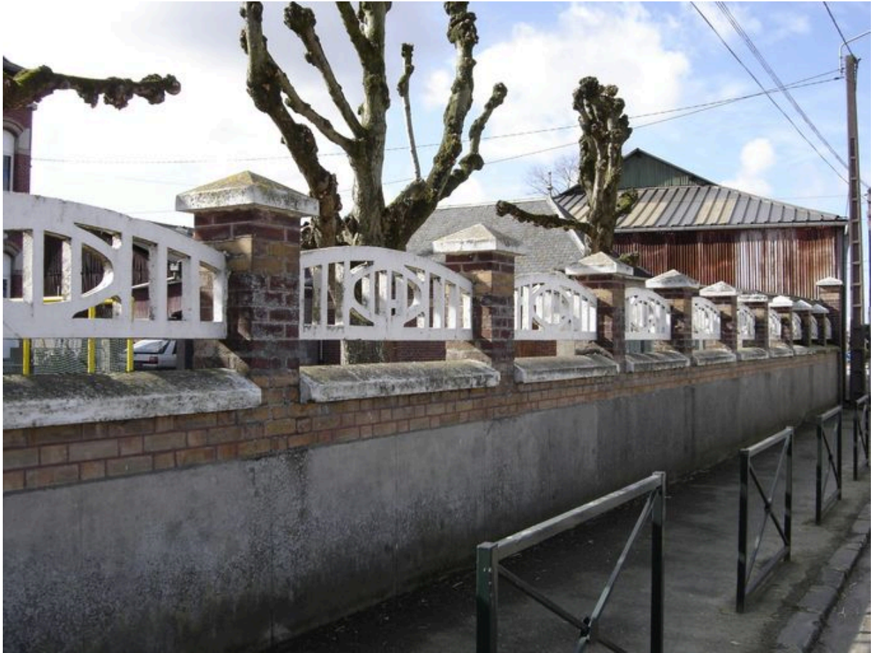
Vue de la clôture d'enceinte.
