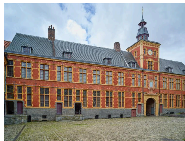
Cour d'honneur, élévation du bâtiment renfermant le passage d'entrée, fermant le côté sud de la cour, vue de trois quarts gauche. Phot. Pierre Thibaut IVR32_20165900892NUCA
