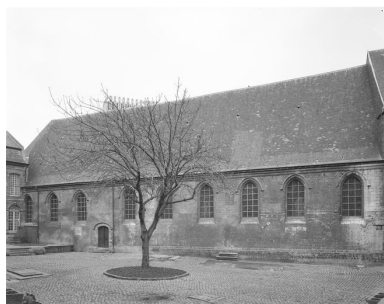
Cour principale, élévation du bâtiment situé au nord de la cour, qui abrite la grande salle des malades et la chapelle, vue générale. Phot. Philippe Dapvril IVR31_20005900320V
