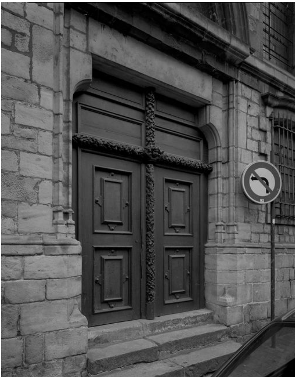
Grande salle des malades, élévation sur la rue Comtesse, détail de la porte d'entrée.
