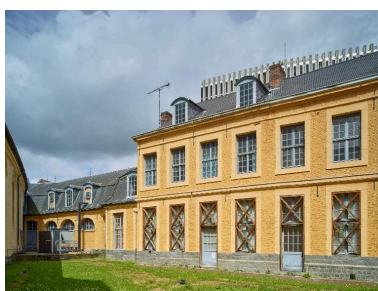
Cour secondaire, élévation du bâtiment situé au nord de la cour, qui abritait la salle de classe et le logement de l'économe, vue de trois quarts droit. Phot. Pierre Thibaut IVR32_20165900901NUCA
