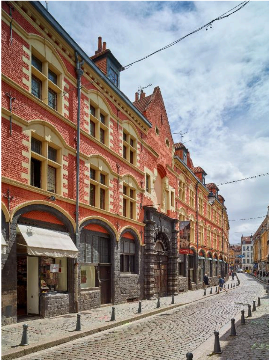
Alignement des maisons dépendant de l'hospice qui se dressent le long de la rue de la Monnaie et au milieu desquelles s'ouvre le portail d'entrée dans la cour d'honneur, vue en enfilade prise depuis le côté gauche.
