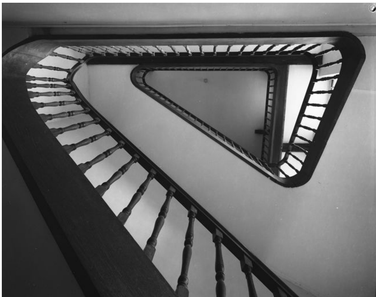
Corps de logis dit des vieillards, construit en 1724, fermant le côté ouest de la cour d'honneur, escalier, vue en contre-plongée.
