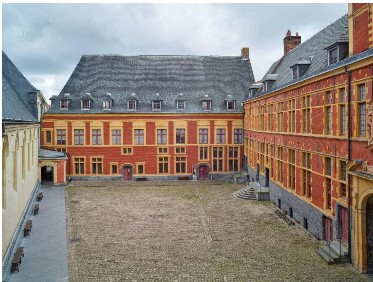
Cour d'honneur, vue générale en regardant vers le bâtiment de la communauté religieuse fermant le côté est de la cour.
