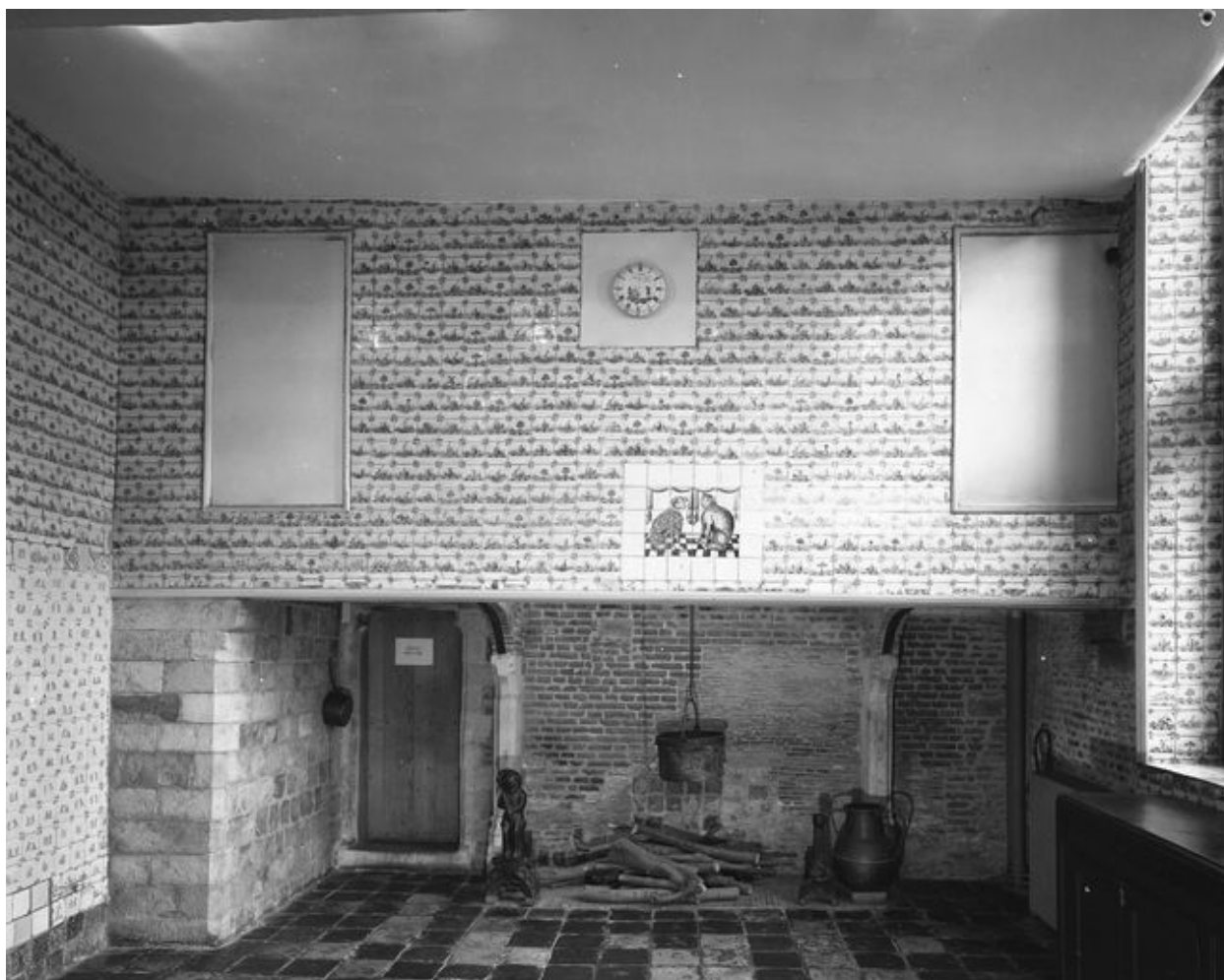
Bâtiment de la communauté religieuse, rez-de-chaussée, ancienne cuisine, cheminée, vue générale.
