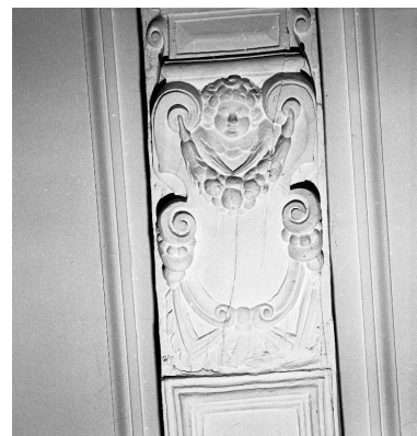
Bâtiment qui s'élève au revers des maisons bordant la rue de la Monnaie, rez-de-chaussée, ancienne infirmerie, actuellement centre de documentation, détail du sabot d'une poutre.
