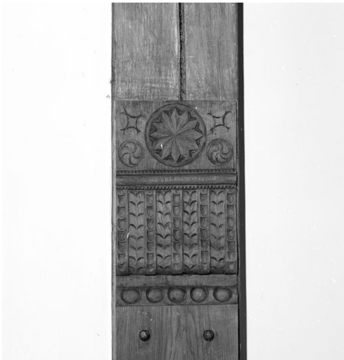
Bâtiment qui s'élève au revers des maisons bordant la rue de la Monnaie, rez-de-chaussée, salle située dans le prolongement de l'ancienne infirmerie, actuellement bureau du conservateur, détail du sabot d'une poutre.
