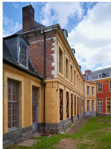
Cour secondaire, élévation du bâtiment situé au nord de la cour, qui abritait la salle de classe et le logement de l'économe, vue en enfilade prise depuis le flanc gauche.
