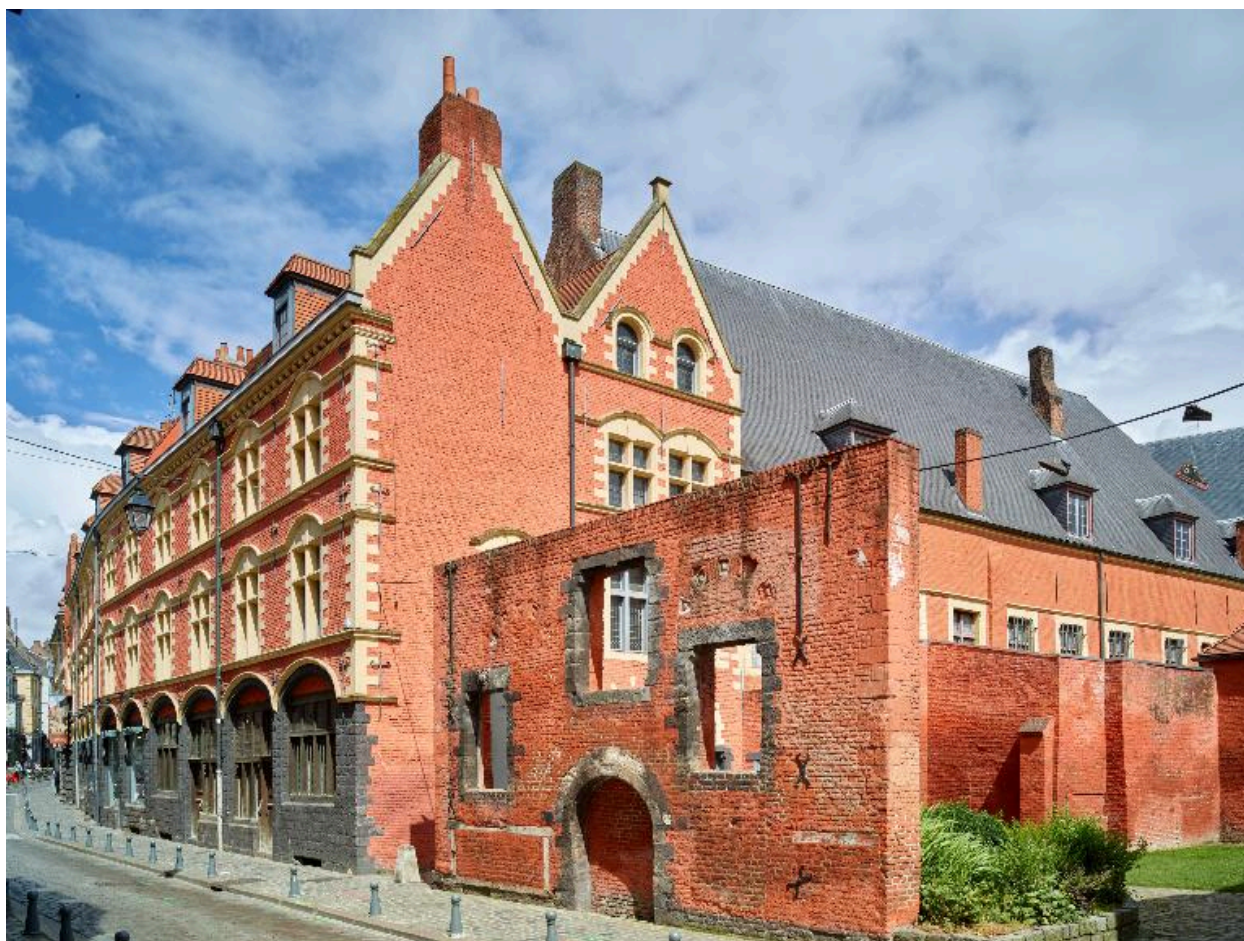
Façade de l'ancien moulin de l'hospice, vue de trois quarts droit avec, au second plan, l'alignement de maisons dépendant de l'hospice et donnant sur la rue de la Monnaie.
