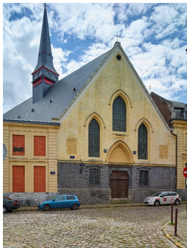
Bâtiment abritant la grande salle des malades, élévation de sa façade donnant sur la rue Comtesse, vue prise de trois quarts gauche. Phot. Pierre Thibaut IVR32_20165900914NUCA
