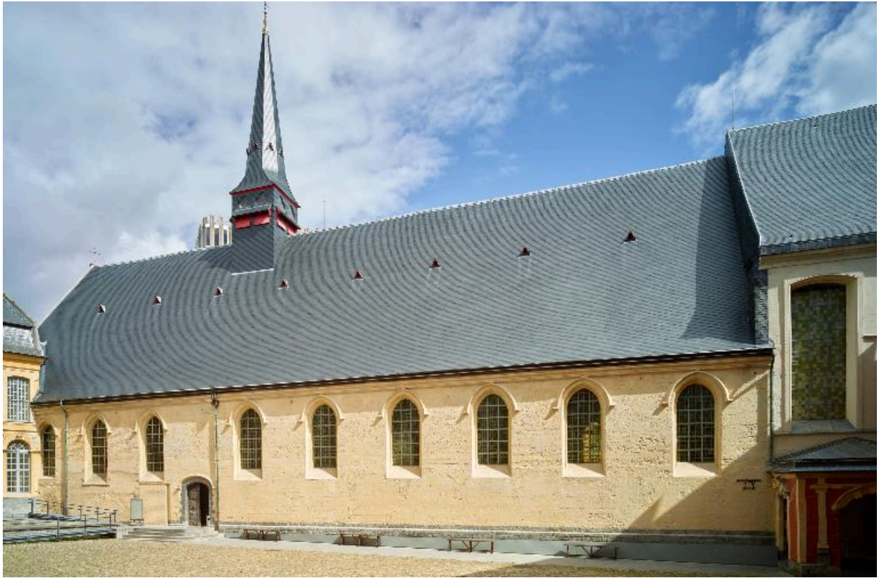
Bâtiment abritant la grande salle des malades, élévation sur la cour d'honneur prise de trois quarts droit.
