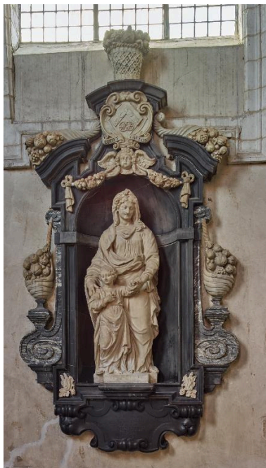
Chapelle, intérieur, abside, flanc droit, détail de la niche abritant un groupe sculpté de Sainte-Anne et la Vierge.
