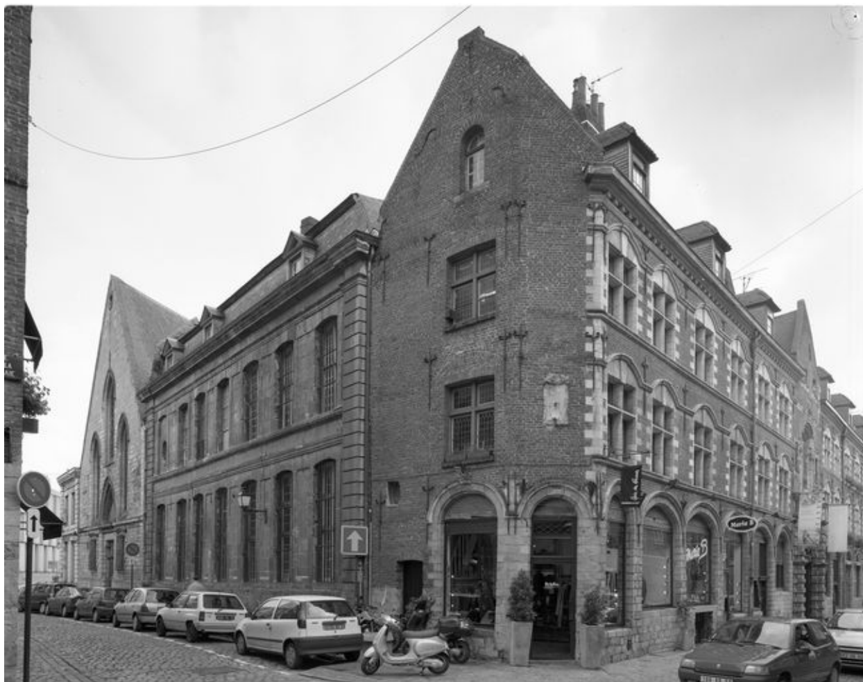
Bâtiment construit en 1724, fermant le côté ouest de la cour principale, élévation postérieure donnant sur la rue Comtesse, vue générale prise de trois quarts droit montrant le début des maisons bordant la rue de la Monnaie.
