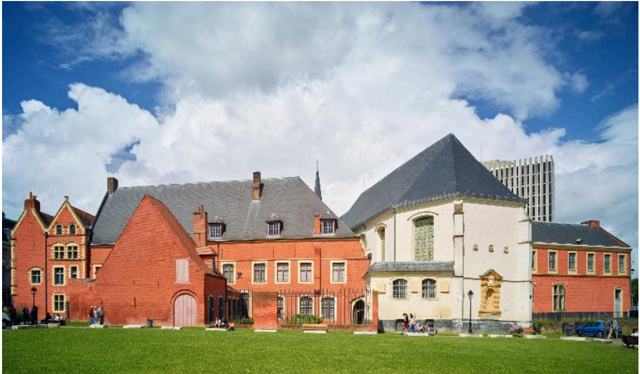
Élévation postérieure, face orientale, revers du bâtiment de la communauté religieuse avec, sur la droite, le chevet de la chapelle.
