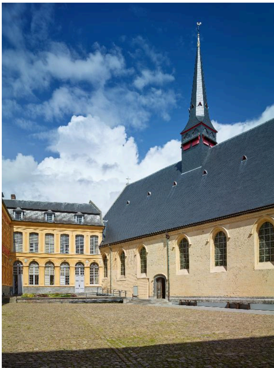
Cour d'honneur, vue générale en regardant vers l'angle formé par le corps de logis dit des vieillards, construit en 1724, fermant le côté ouest de la cour, et celui abritant la grande salle des malades.
