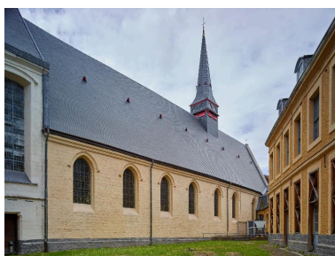
Cour secondaire, élévation du bâtiment abritant la grande salle des malades.
