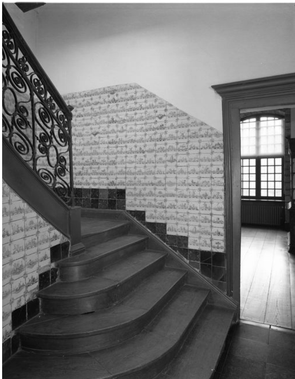
Bâtiment de la communauté religieuse, rez-de-chaussée, escalier, départ : revêtement mural en carreaux de faïence de Lille.
