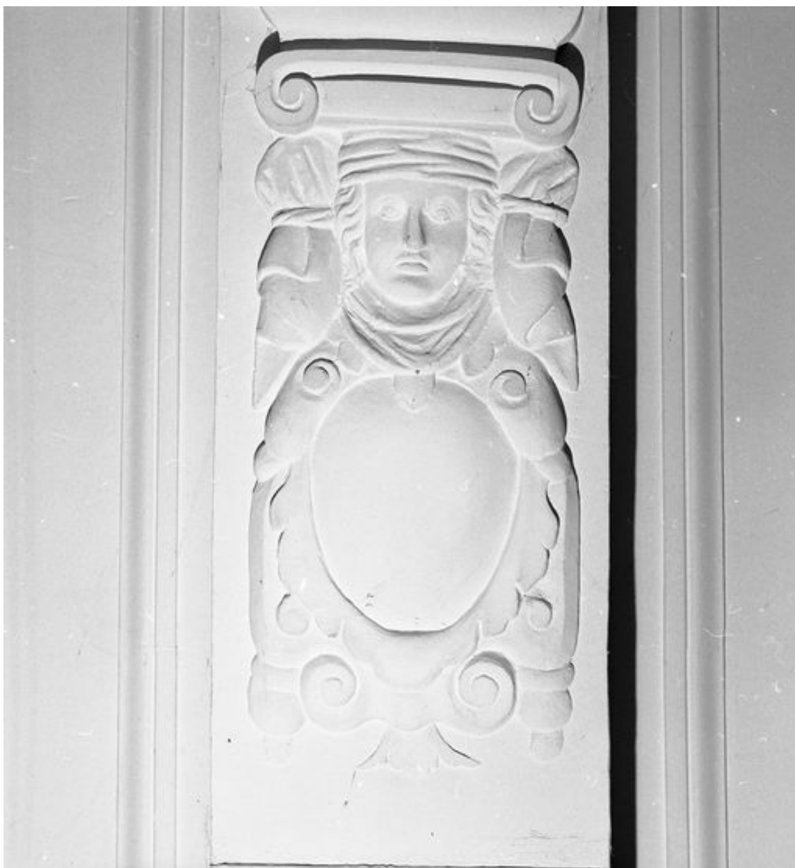
Bâtiment qui s'élève au revers des maisons bordant la rue de la Monnaie, rez-de-chaussée, ancienne infirmerie, actuellement centre de documentation, détail du sabot d'une poutre.
