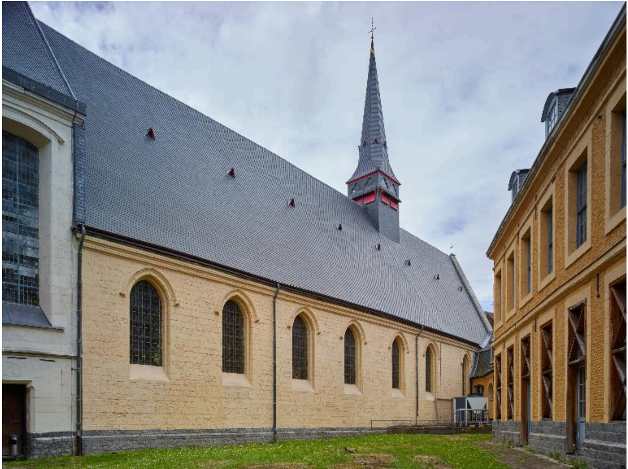
Cour secondaire, élévation du bâtiment abritant la grande salle des malades.
