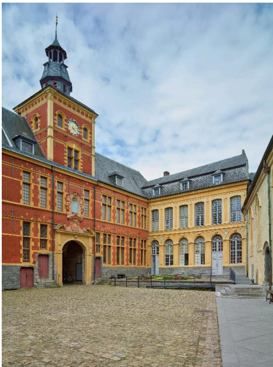
Cour d'honneur, vue générale en regardant vers l'angle formé par bâtiment renfermant le passage d'entrée, fermant le côté sud de la cour, et celui situé à sa droite fermant le côté ouest.
