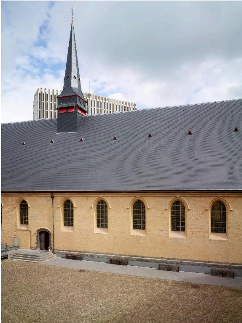
Bâtiment abritant la grande salle des malades, élévation sur la cour d'honneur prise en légère plongée de trois quarts droit.
