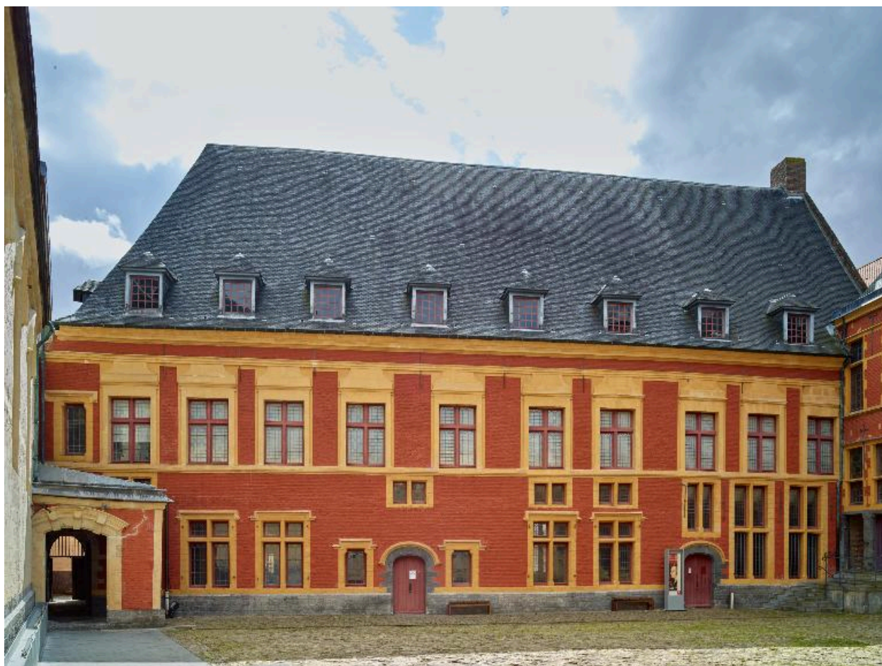
Cour d'honneur, élévation du bâtiment de la communauté religieuse fermant le côté est de la cour, vue de face.
