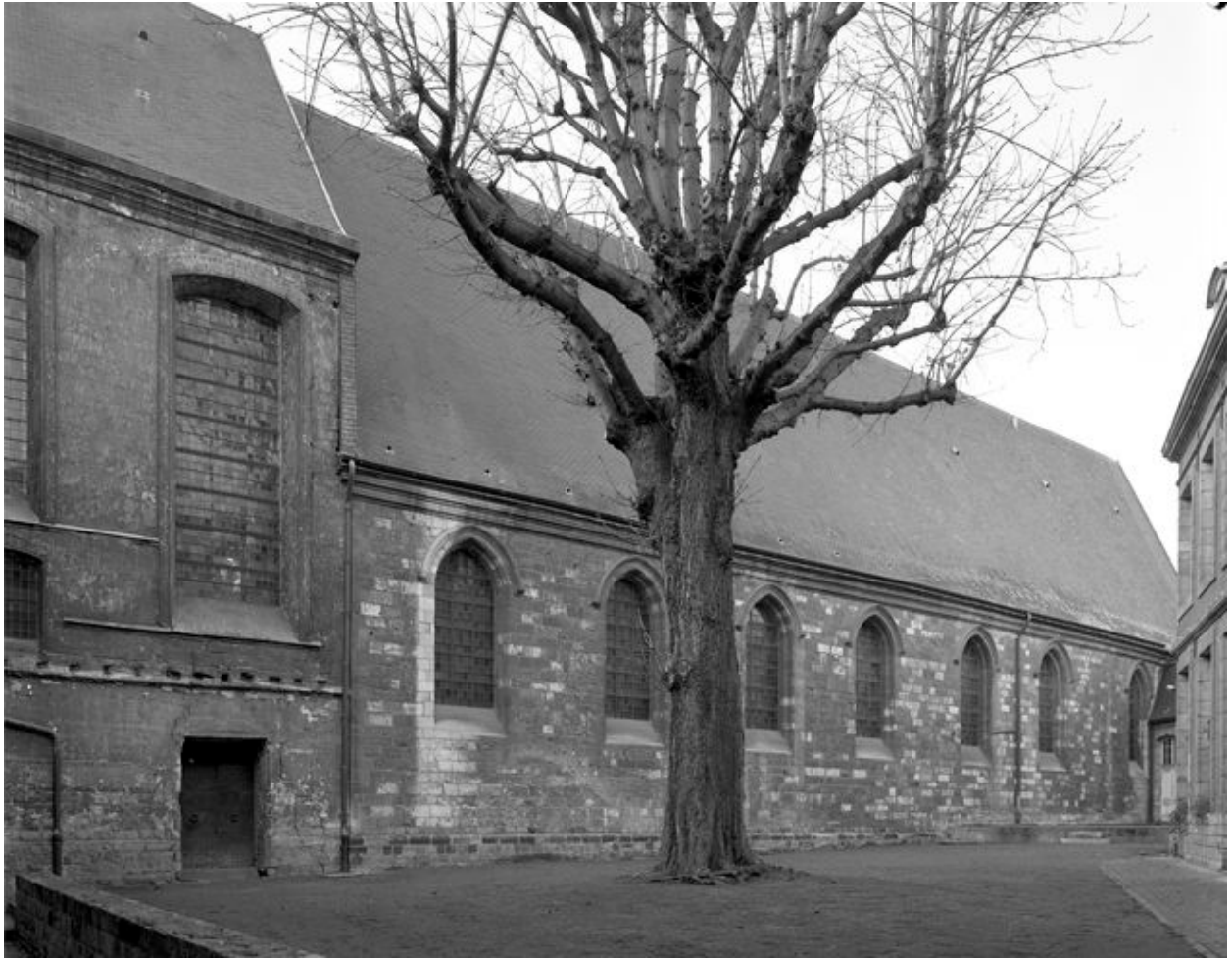
Cour secondaire, élévation du bâtiment situé au sud de la cour, abritant la grande salle des malades et la chapelle.
