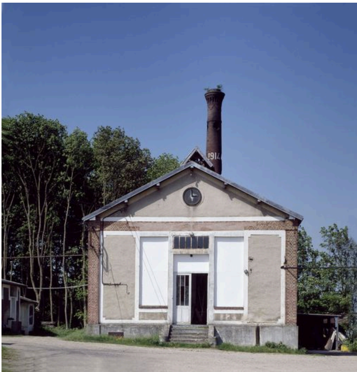
La chaufferie de l'ancienne broserie Comelin-Brénier à Tracy-le-Mont
