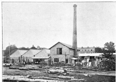
COMPIEGNE. Scierie A. Baudouin ? Phot. Thierry Lefébure IVR22_19946000709XB
