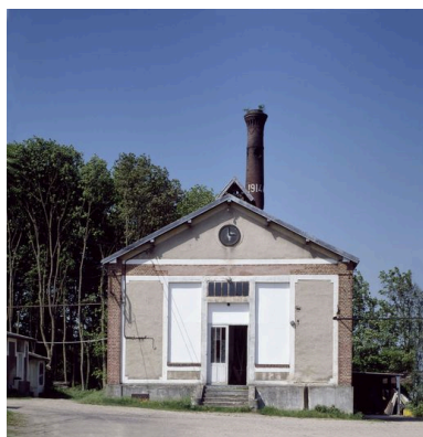
La chaufferie de l'ancienne broserie Comelin-Brénier à Tracy-le-Mont Phot. Patrick Glotain IVR22_19936001826XA
